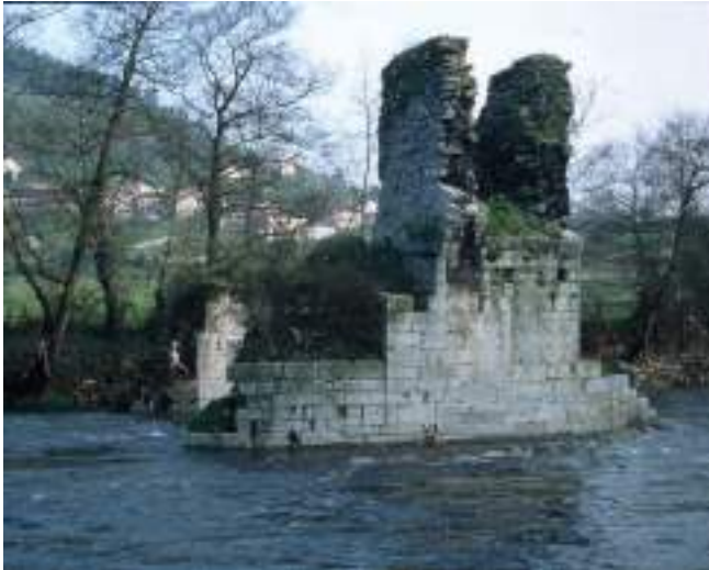
Figura 216. Pila central desde Trubia, con restos de las obras de reconstrucción. (J. Belón González)
