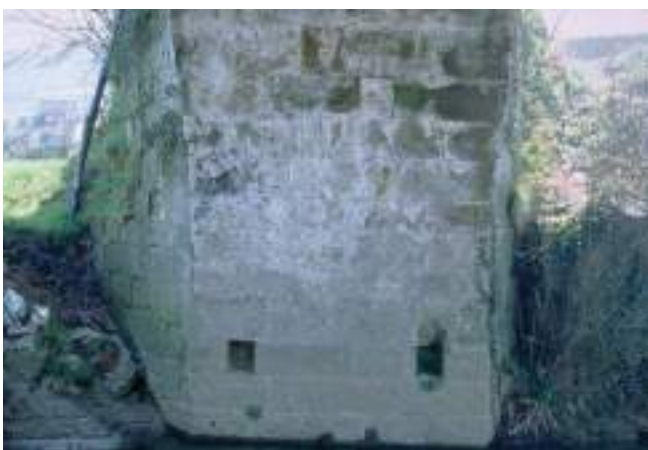
Figura 68. Estribo de la margen izquierda, con los paramentos que se abren para encauzar el agua. (J. Belón González)
