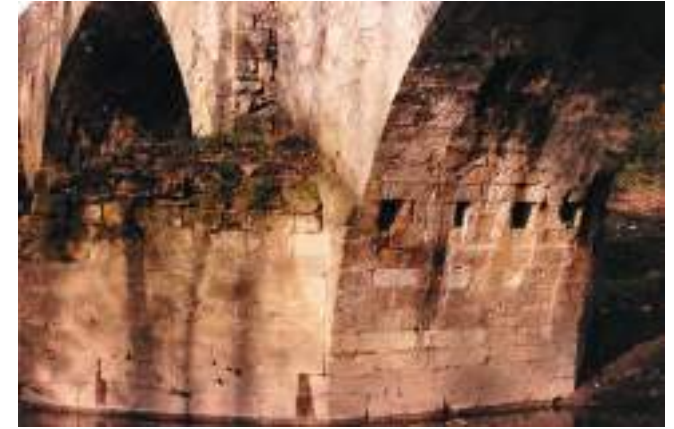
Figura 59. Aguas arriba, unión entre tajamar y arco derecho, con mechinales más elevados que el izquierdo, y marca cruciforme en la segunda hilada. (J. M. Fdez. Hevia)
