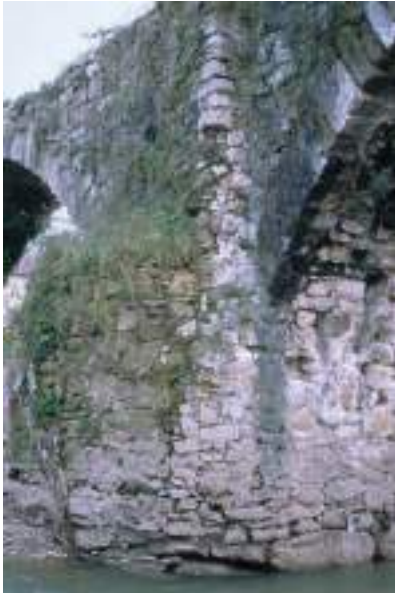
Figura 25. Contrafuerte, aguas abajo. (J. M. Fdez. Hevia)
