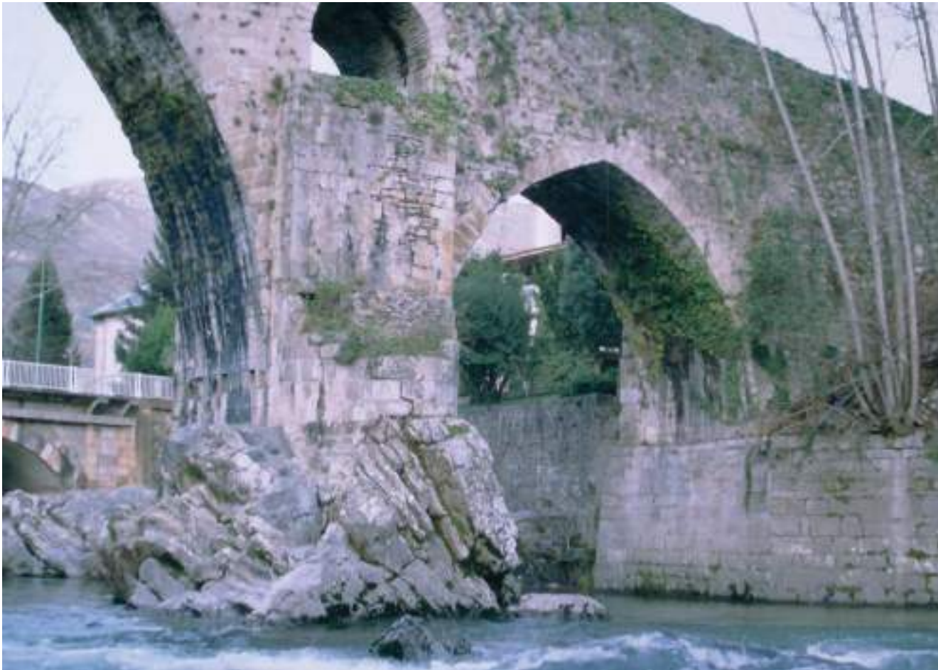
Figura 44. Aguas arriba, pila central y arco menor hacia Cangas con nuevo arranque y muro de encauzamiento, fruto de las intervenciones de mediados del siglo XIX. (J. M. Fdez. Hevia)
