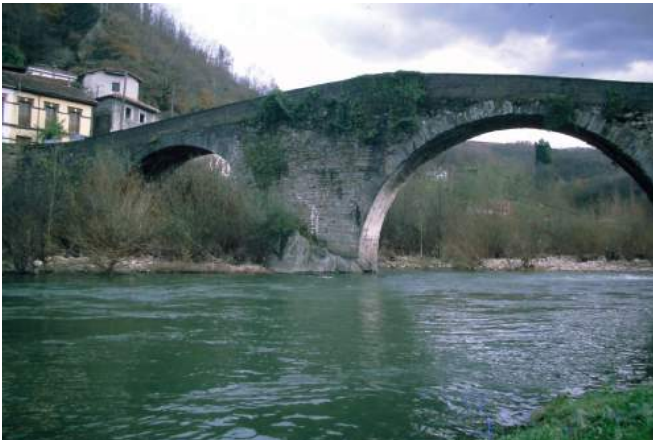
Figura 191. Vista del puente de Arco, aguas abajo. (J. M. Fdez. Hevia)
