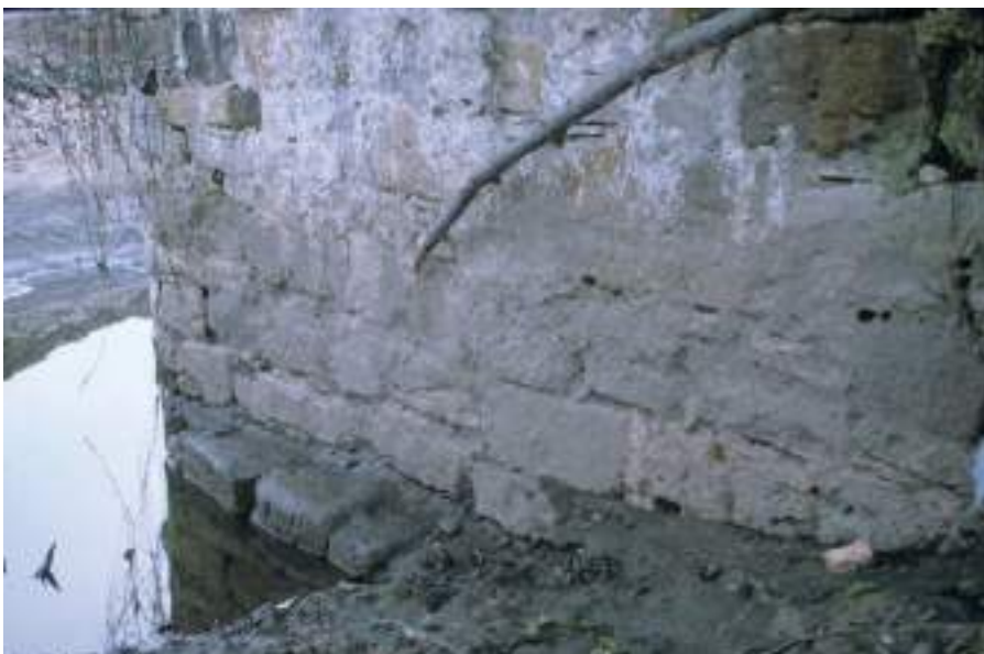
Figura 28. Arranque de la pila del puente hacia Oviedo, sobre una plataforma. (J. M. Fdez. Hevia)
