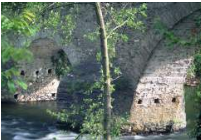
Figura 277. Detalle del intradós de la bóvedas. (J. M. Fdez. Hevia)
