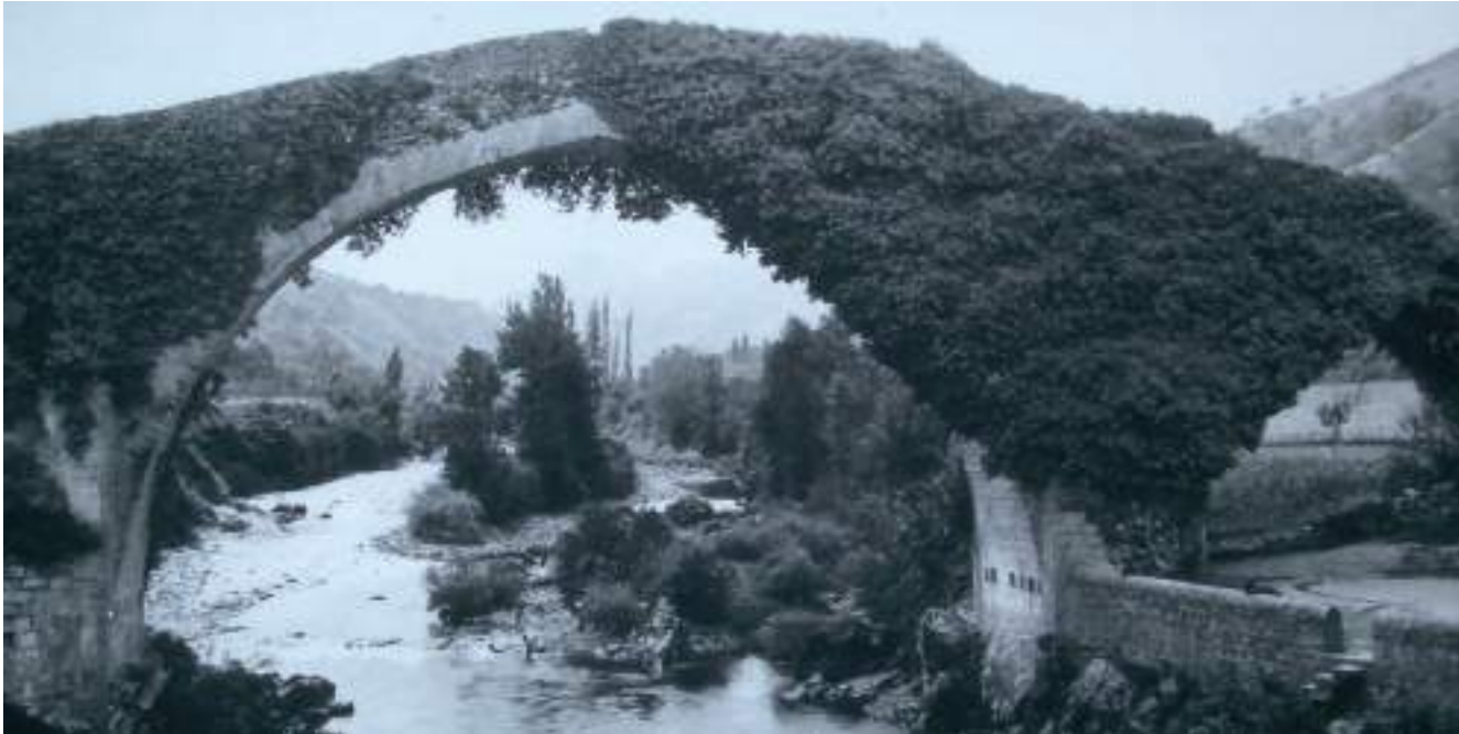
Figura 41. Aguas abajo, el puente con el espolón roto en la margen de Parres, a principios del siglo xx. (Col. M. Carrasco Marqués)
