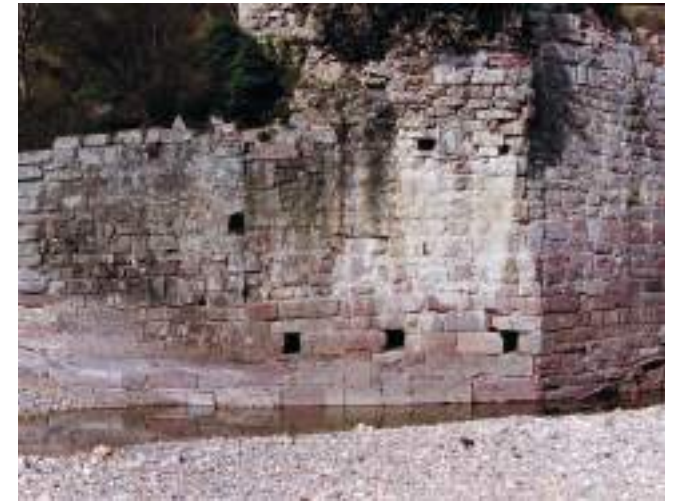
Figura 221. Pila izqda de la bóveda: fábrica de sillar, espolón y restos del arranque de la bóveda mayor. (J. Belón González)
