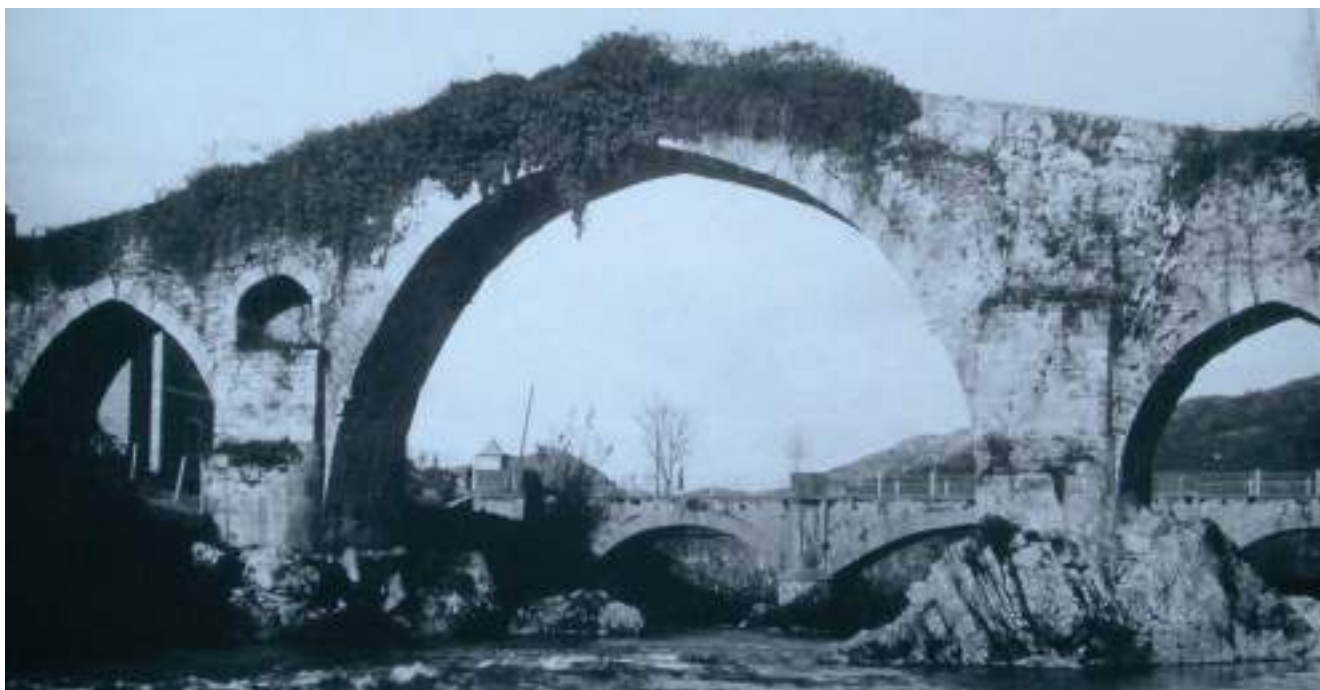
Figura 40. Vista, aguas arriba, probablemente a finales del siglo XIX, con los arquillos cegados; el izquierdo, parcialmente; y el derecho, además, roto. (Col. M. Carrasco Marqués)
