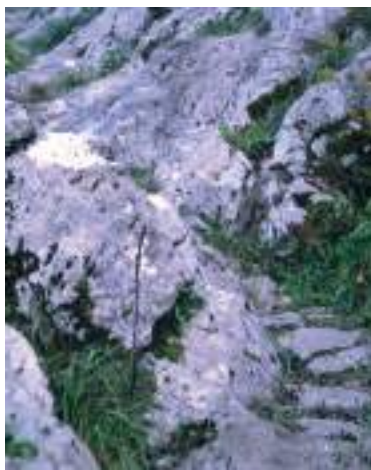
Figura 157. Camino de herradura excavado en roca. (J. M. Fdez. Hevia)
