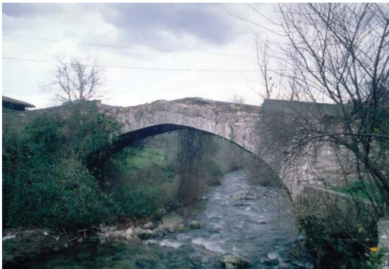
Figura 182. Puente de Soto de Aguas. (J. M. Fdez. Hevia)
