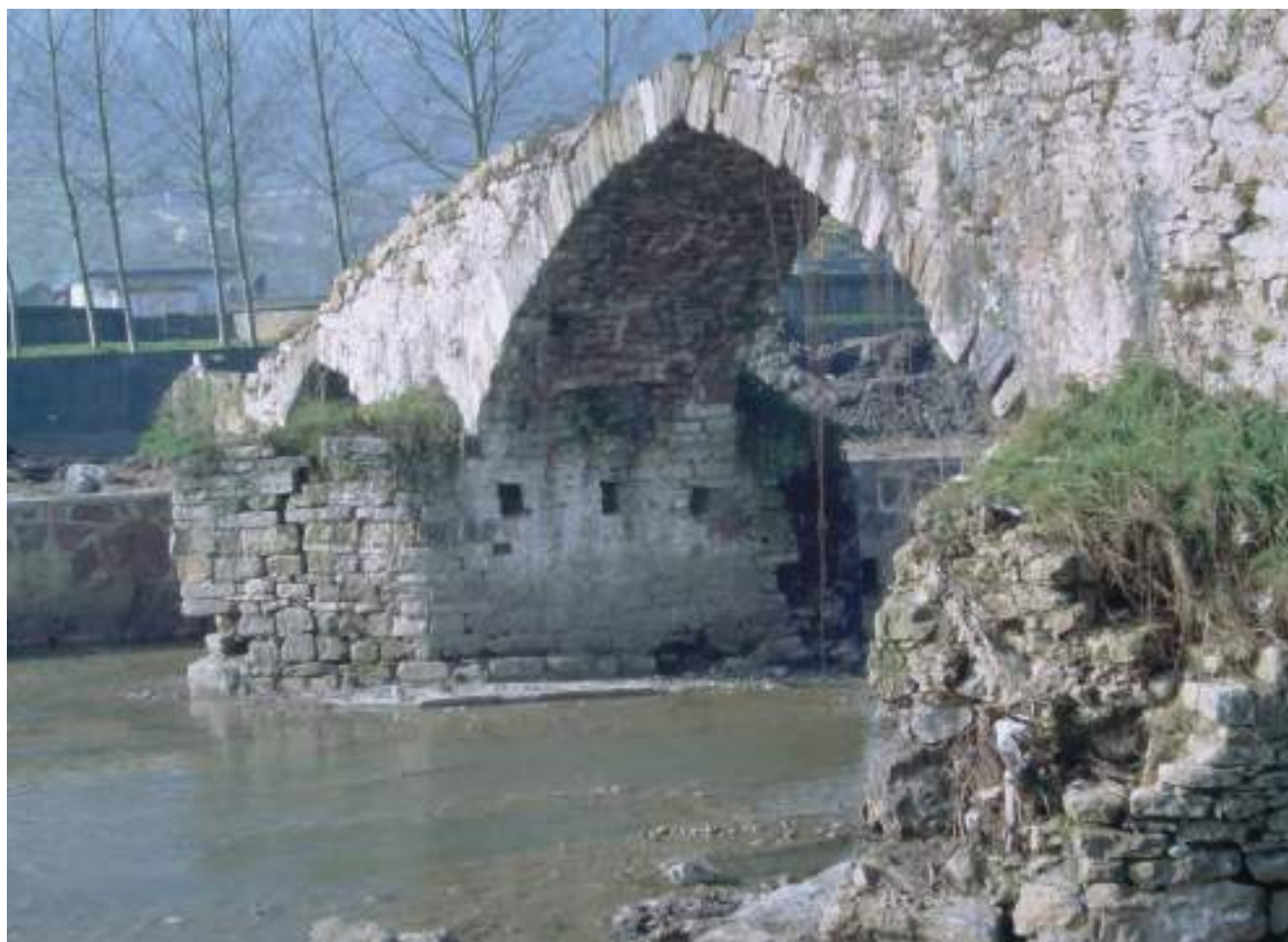
Figura 24. Vista lateral del puente, aguas arriba. (J. Belón González)
