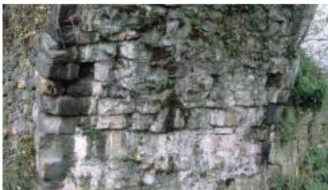
Figura 13. Detalle de la fábrica en el intradós de la bóveda mayor. (J. Belón González)
