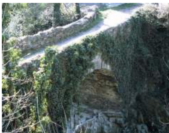
Figura 248. Vista, aguas arriba. (J. Belón González)
