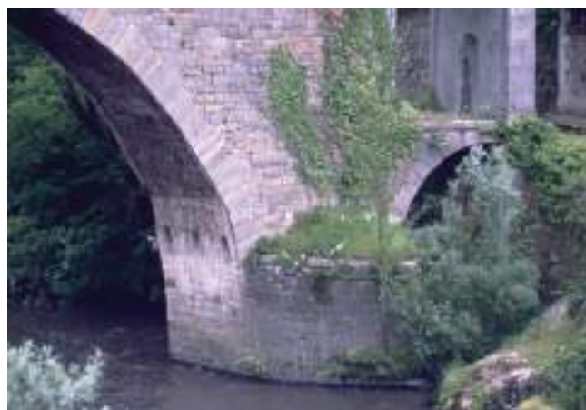
Figura 91. Vista parcial de la remodelación del primer vano, en el siglo XX. (J. M. Fdez. Hevia)
