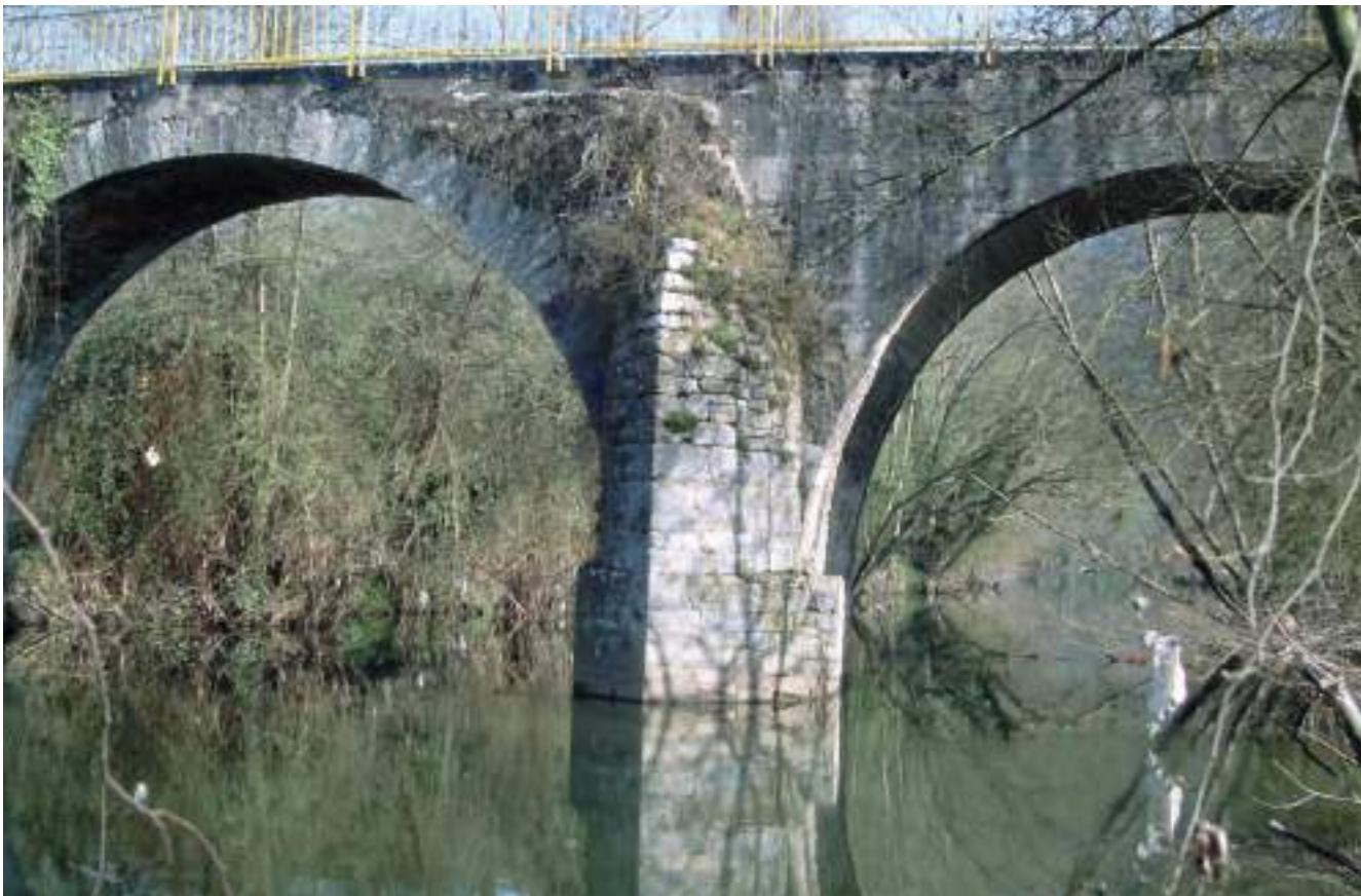
Figura 76. Vista de los arcos centrales, tímpanos reconstruidos de hormigón y detalle del espolón. (J. Belón González)
