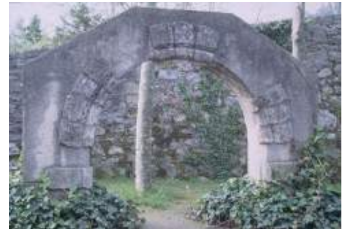
Figura 38. Restos de arquivolta románica, extraídos de la fábrica del puente durante la reconstrucción de Luis Menéndez Pidal. (J. M. Fdez. Hevia)
