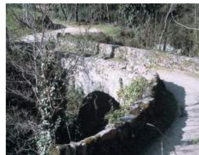
Figura 250. Acceso al puente y vista parcial del paramento, aguas abajo. (J. Belón González)
