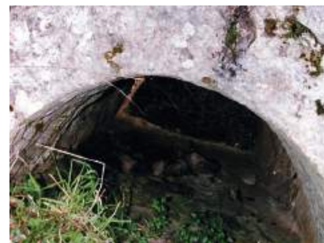
Figura 165. Detalle del interior del arquiello. (Elena Ruiz)
