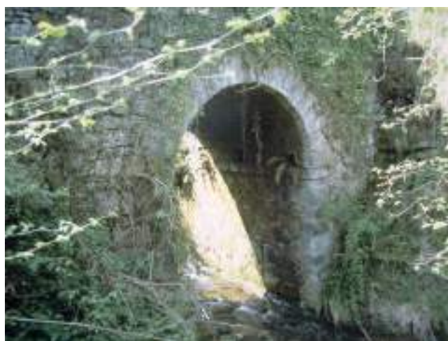
Figura 168. Vista parcial de la bóveda, aguas abajo. (J. Belón González)
