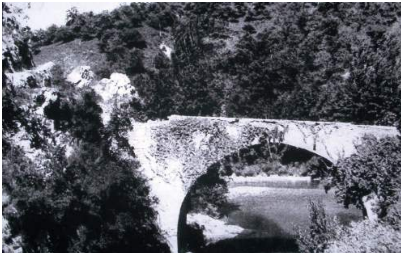
Figura 178. El puente de Los Grazos a mediados del siglo XX. (Carlos Fernández Casado, Historia del puente en España)
