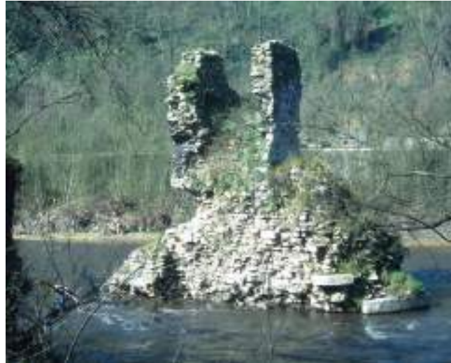
Figura 217. Restos de la pila central con estabilidad muy comprometida, desde Godos. (J. Belón González)
