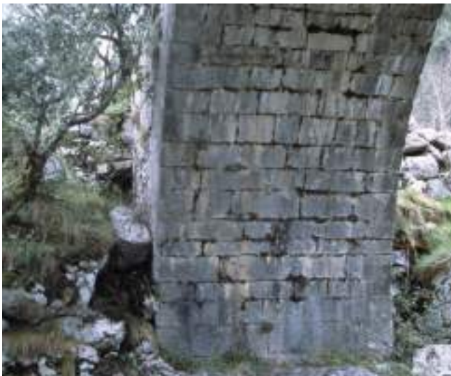
Figura 147. Cimentación y arranque del arco del puente de Berodia. (J. Belón González)
