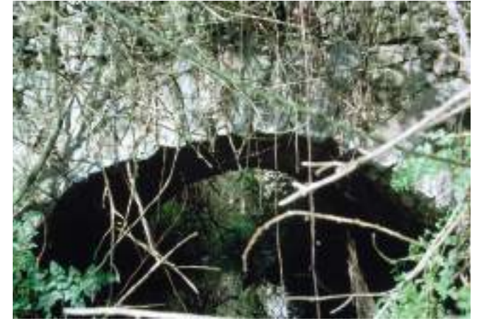
Figura 109. Arquillo de desagüe lateral. (J. Belón González)
