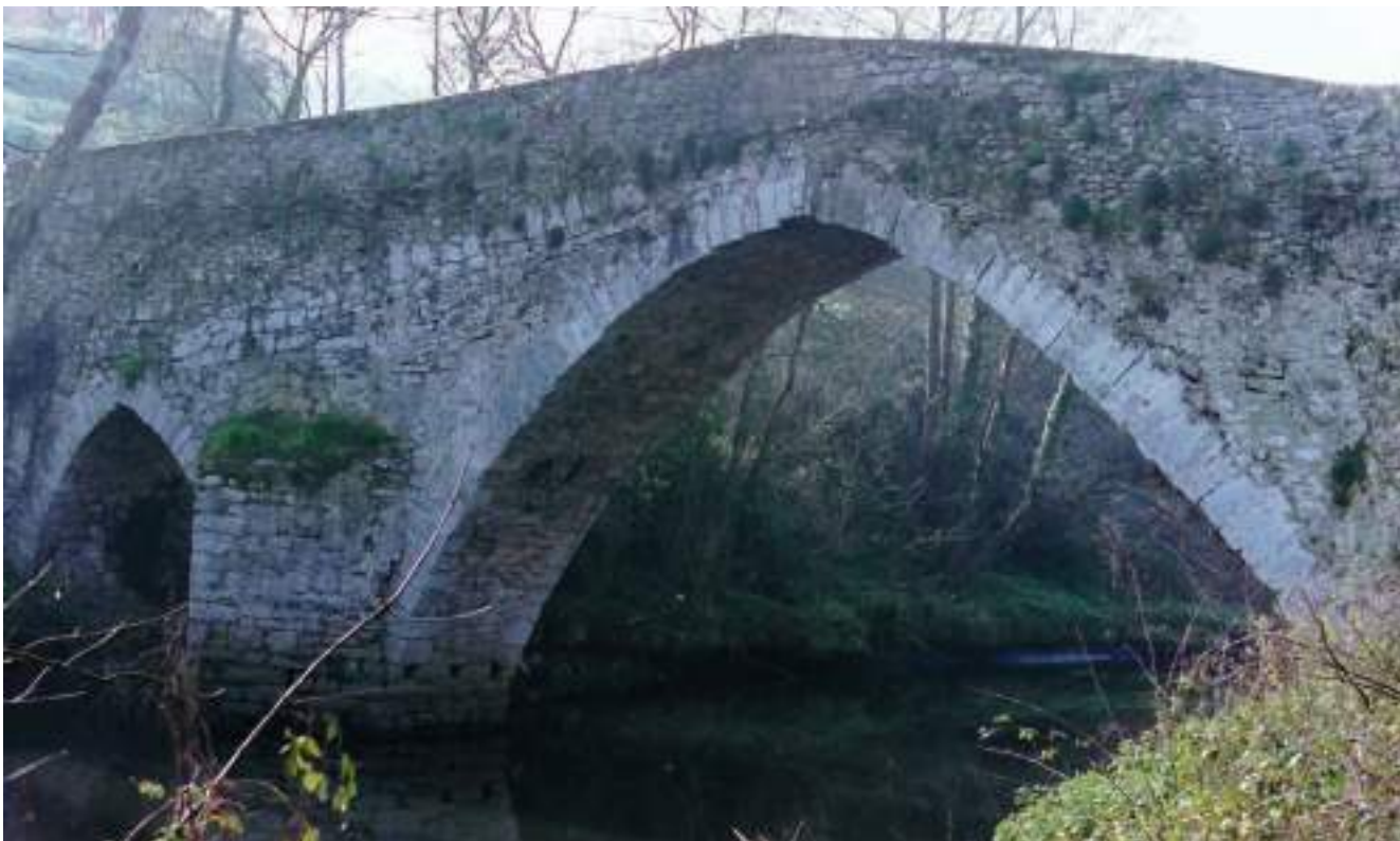
Figura 83. Vista de los arcos y tajamar, aguas arriba. (J. Belón González)
