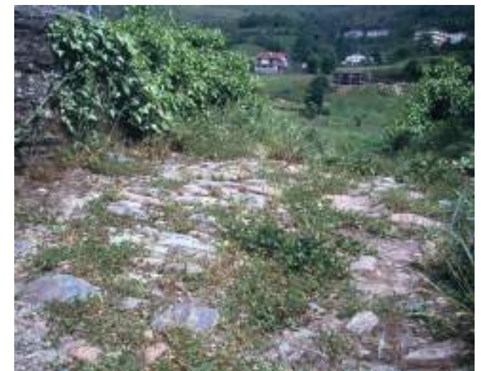
Figura 255. Calzada del puente. (J. M. Fdez. Hevia)
