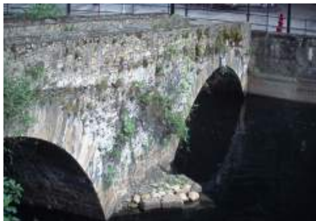
Figura 278. Detalle de la fábrica del puente de Santianes, cortado por la central térmica. (J. M. Fdez. Hevia)
