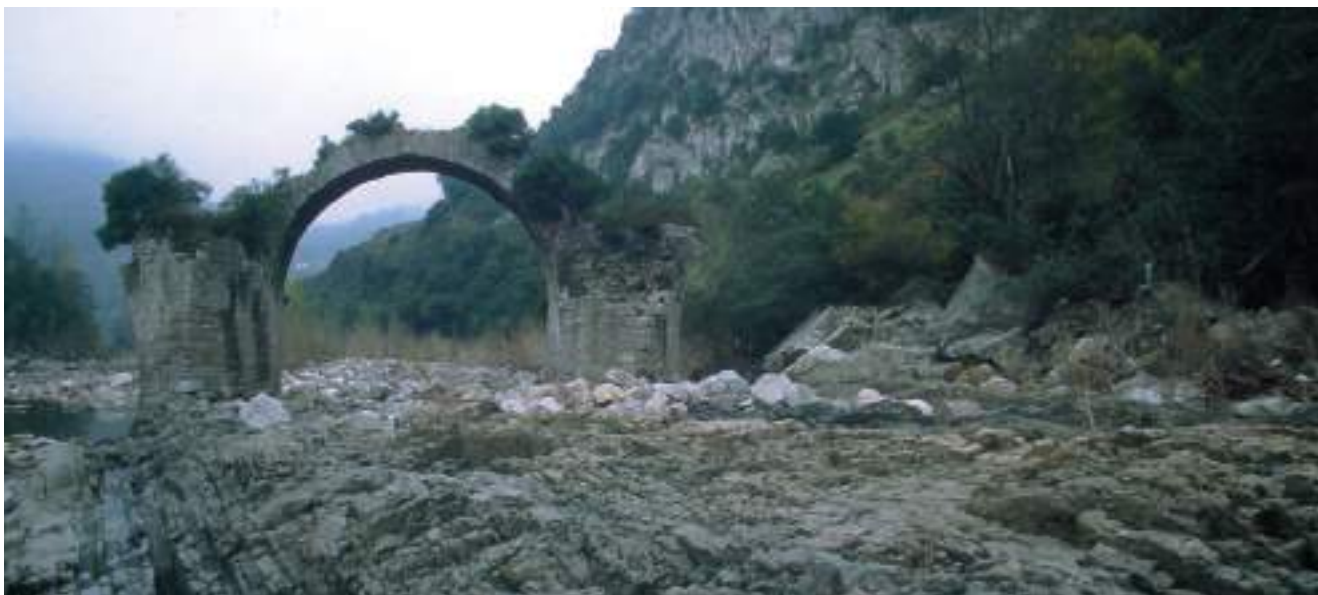
Figura 219. Detalle del afloramiento rocoso en el que apoya el puente. (J. M. Fdez. Hevia)
