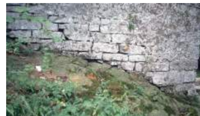
Figura 177. Arranque del estribo izquierdo, aguas abajo. (J. M. Fdez. Hevia)
