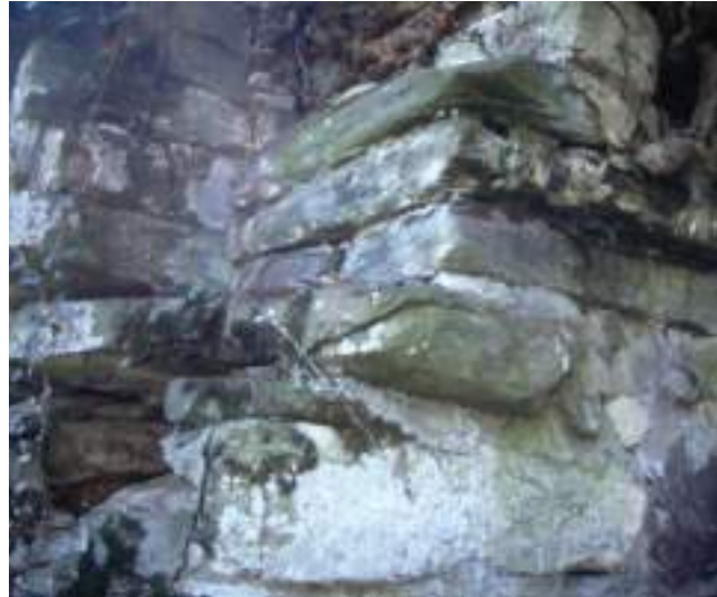
Figura 184. Detalle del arranque de la bóveda reconstruida en la margen izquierda. (J. Belón González)
