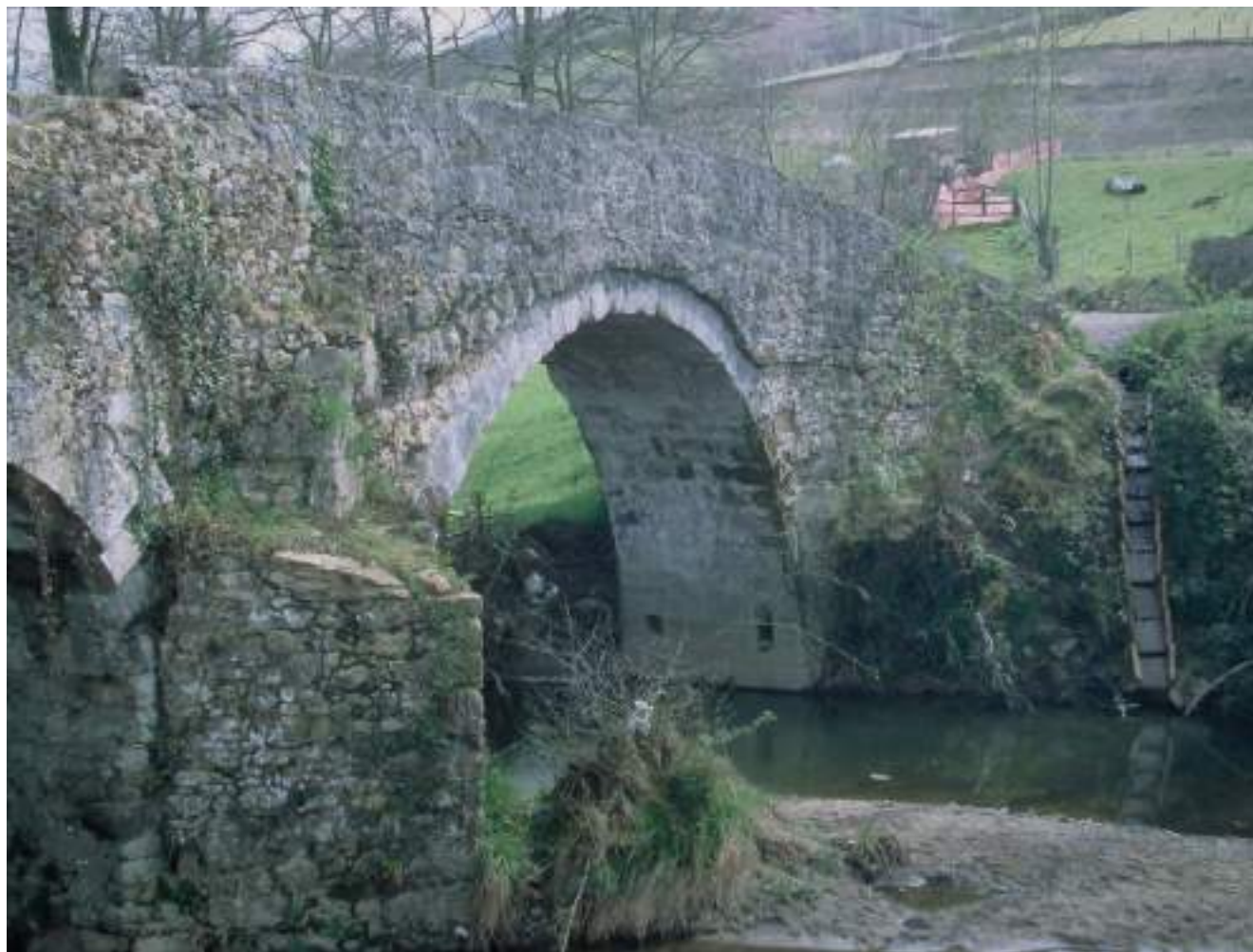
Figura 67. Detalle del ensanchamiento del arco mayor en el siglo XVIII. (J. Belón González)
