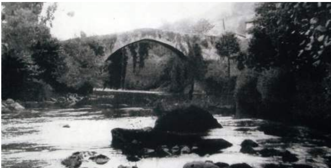
Figura 208. Vista del puente aguas abajo. (Carlos Fernández Casado, Historia del puente en España)
