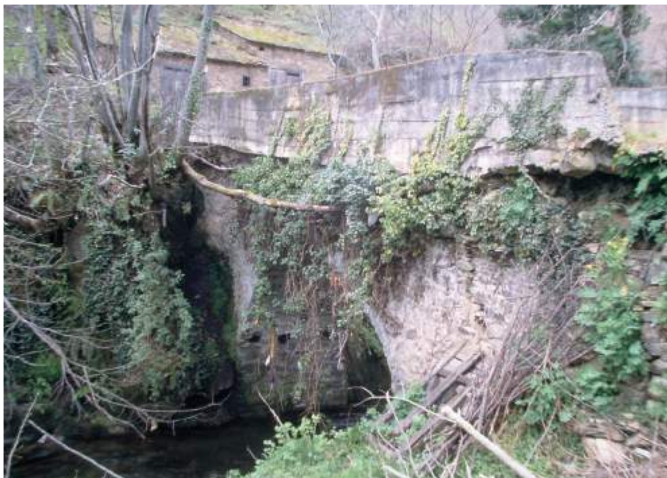
Figura 235. Vista del puente desde aguas arriba. (J. Belón González)
