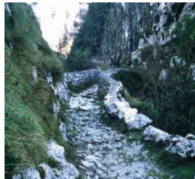
Figura 151. Camino de acceso al puente con su característica forma curva. (J. M. Fdez. Hevia)
