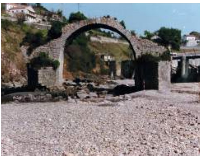
Figura 224. Restos del arranque de la última bóveda de la margen derecha, hacia San Pedro de Nora. (J. Belón González)
