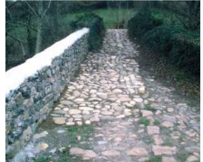
Figura 185. Calzada empedrada, resultado de intervención a finales del XX. (J. M. Fdez. Hevia)
