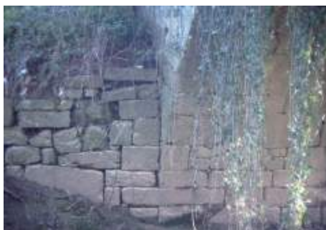
Figura 70. Vista parcial del intradós y muro de encauzamiento en la margen izquierda. (J. Belón González)
