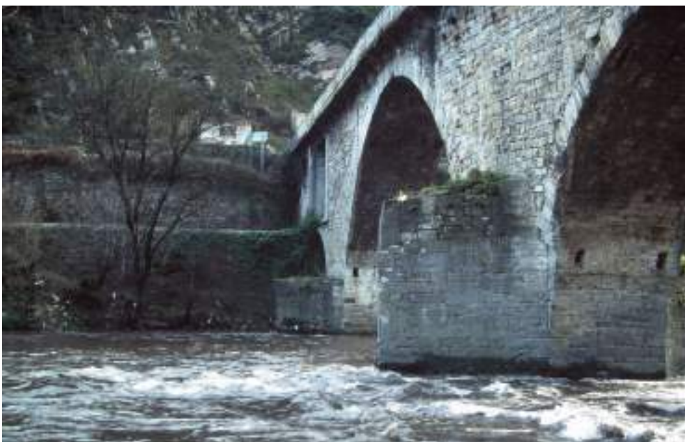
Figura 97. Reconstrucción apreciable de los dos arcos que flanquean la pila del arco menor. (J. M. Fdez. Hevia)
