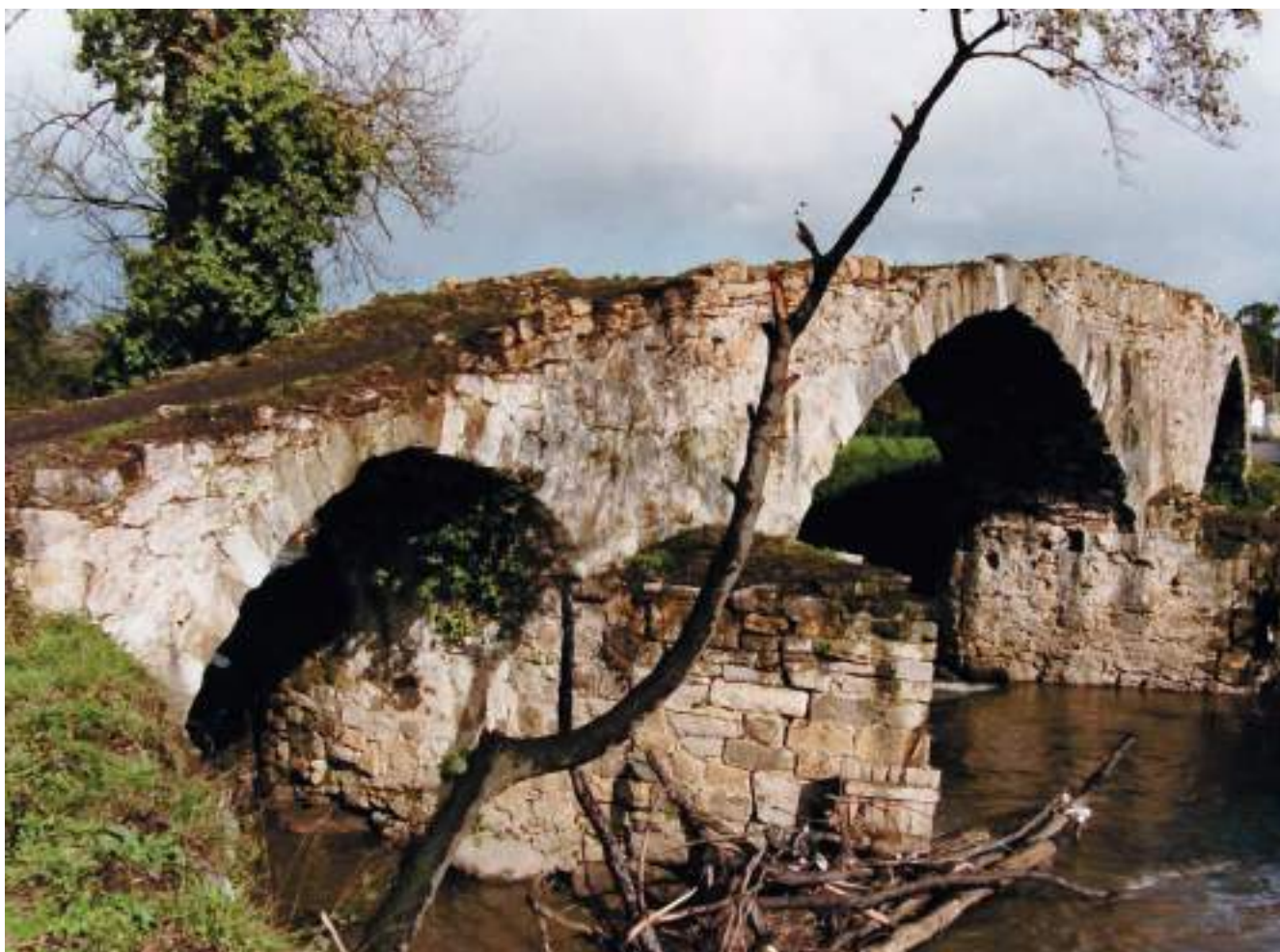
Figura 21. Panorámica a finales del siglo xx, aguas arriba, antes del encauzamiento del río. (Elena Ruiz)
