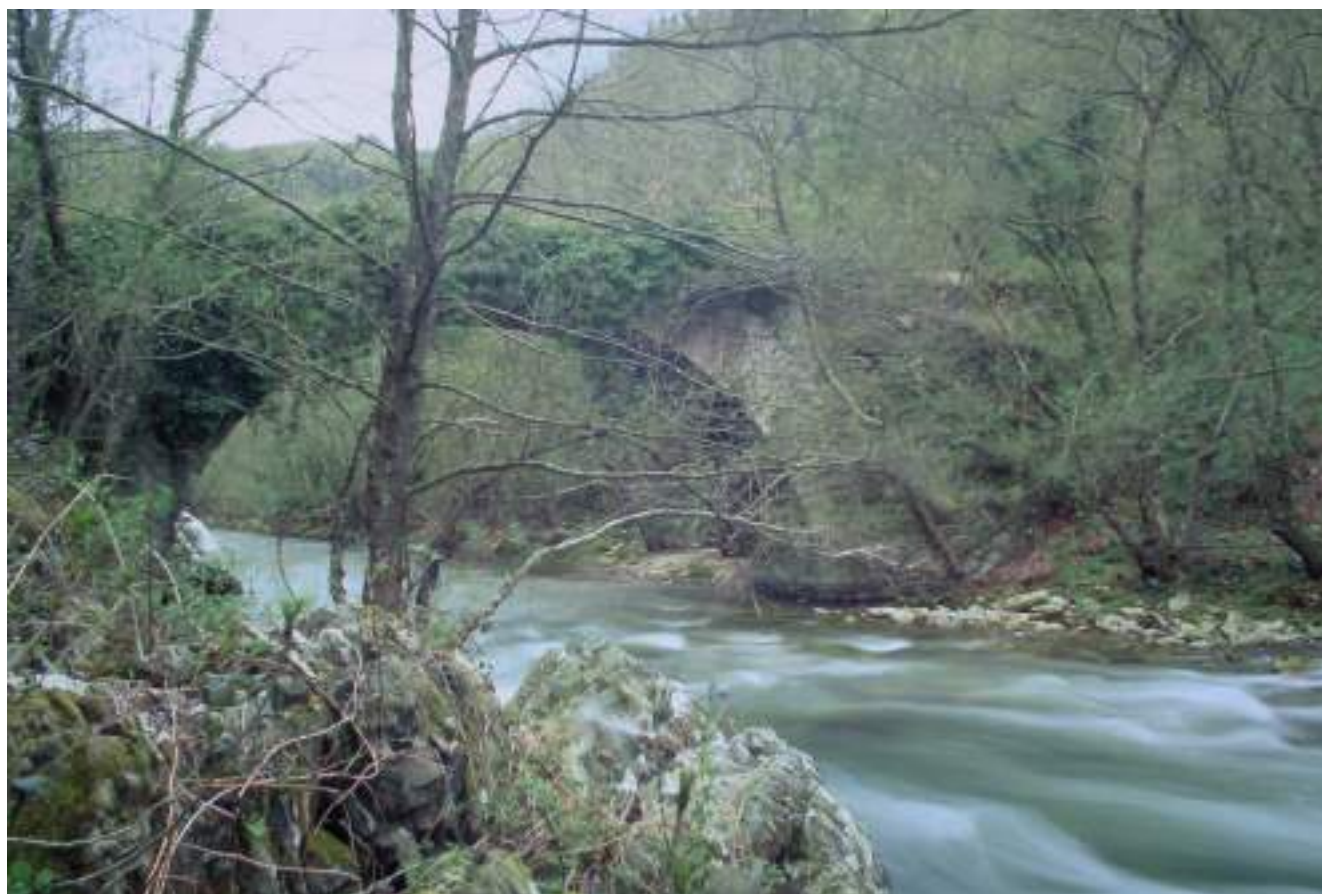
Figura 71. Vista general del puente de Ese de Caeras. (J. M. Fdez. Hevia)
