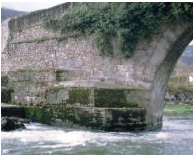
Figura 192. Detalle de la obra de hormigón de mediados del siglo XX, aguas arriba, margen izquierdo. (J. M. Fdez. Hevia)
