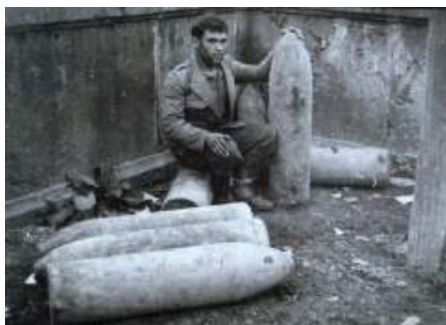
Figura 45d. Proyectiles para la voladura de los puentes. (BNE)
