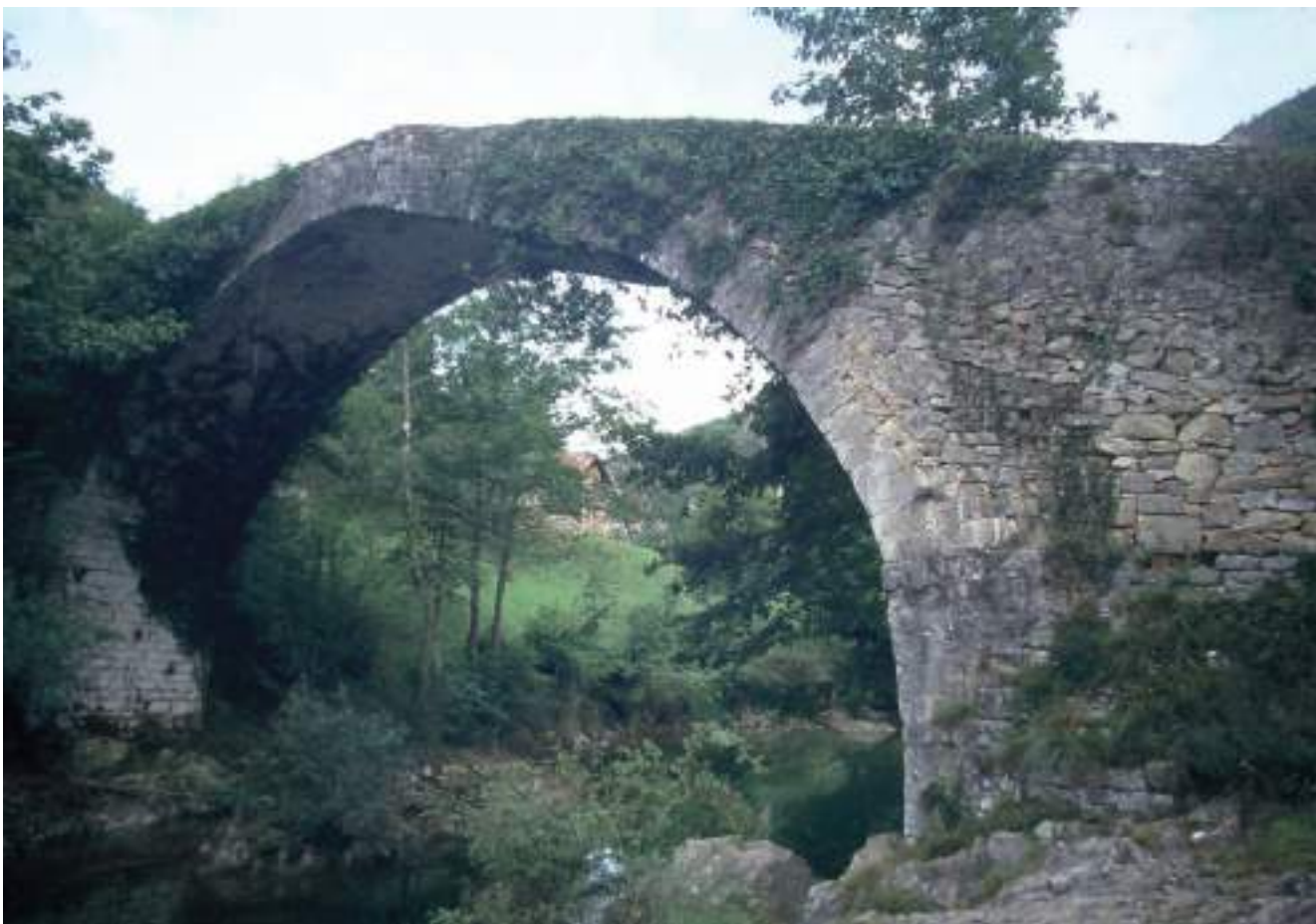
Figura 174. Panorámica general, aguas arriba. (J. M. Fdez. Hevia)
