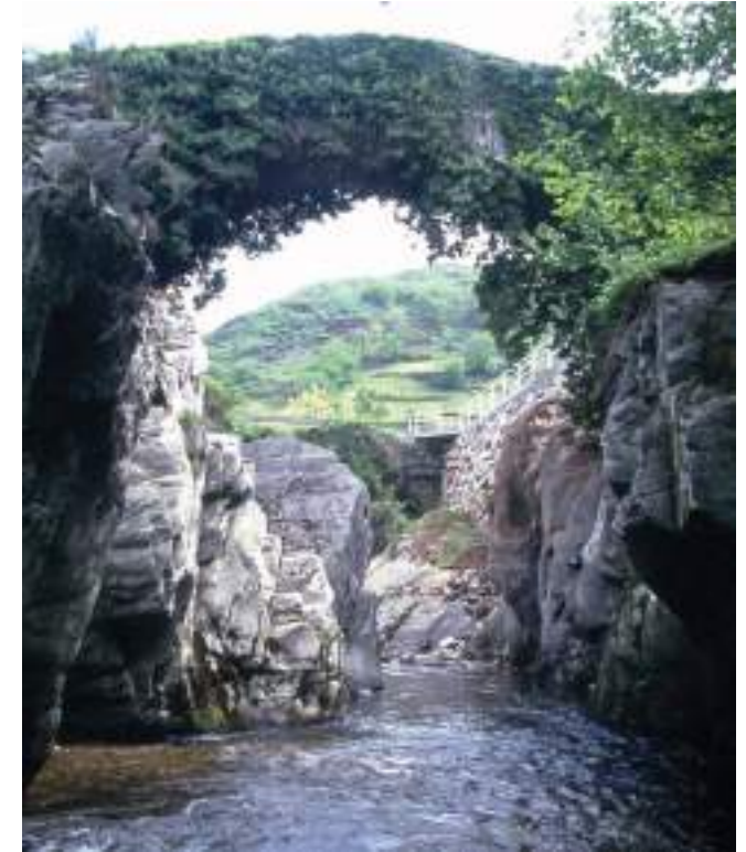
Figura 254. Vista a nivel del río. (J. M. Fdez. Hevia)
