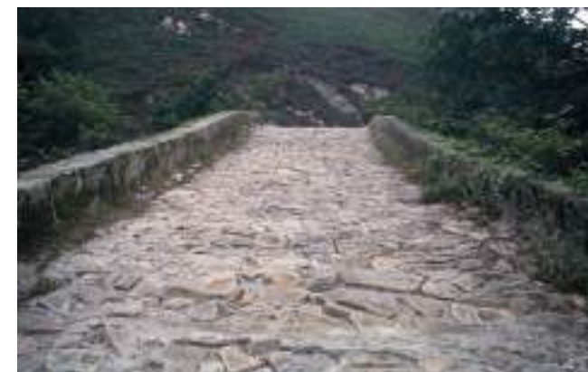
Figura 176. Detalle del empedrado del puente. (J. M. Fdez. Hevia)
