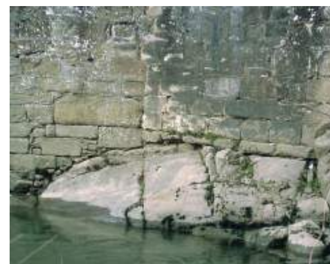
Figura 196. Detalle del apoyo de la pila en el afloramiento intermedio. (J. M. Fdez. Hevia)
