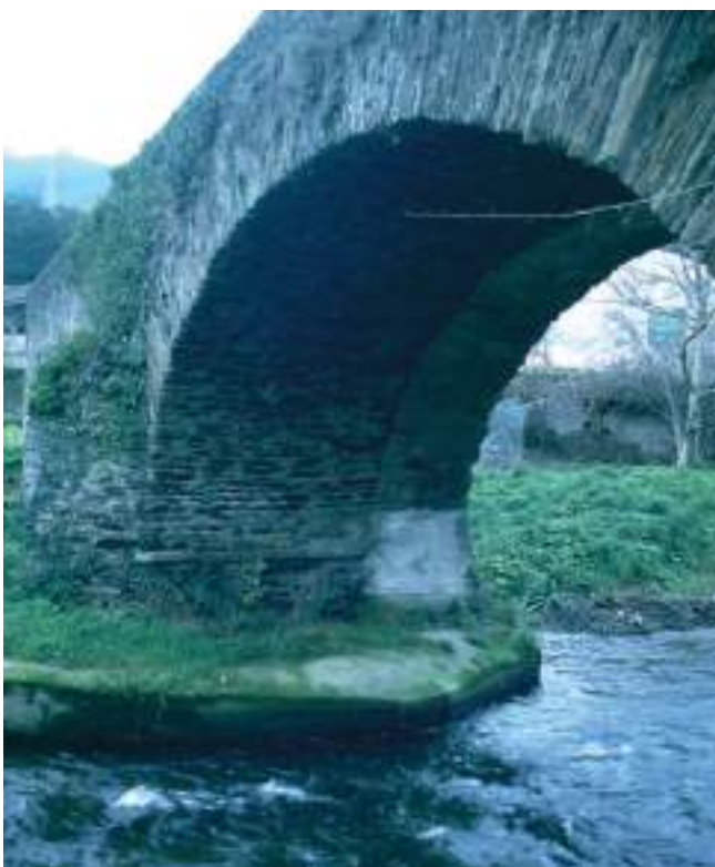
Figura 114. Intradós de la bóveda central ensanchada. (J. M. Fdez. Hevia)
