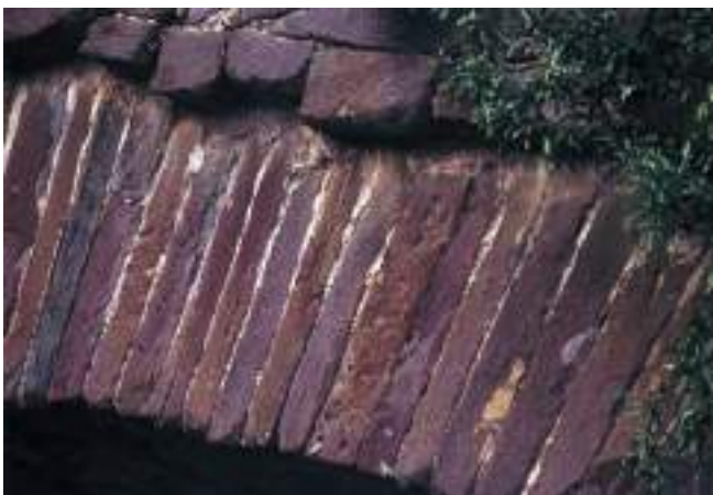
Figura 262. Dóvela reaprovechada del puente, con motivo sogueado. (Jorge Argüello Menéndez)
