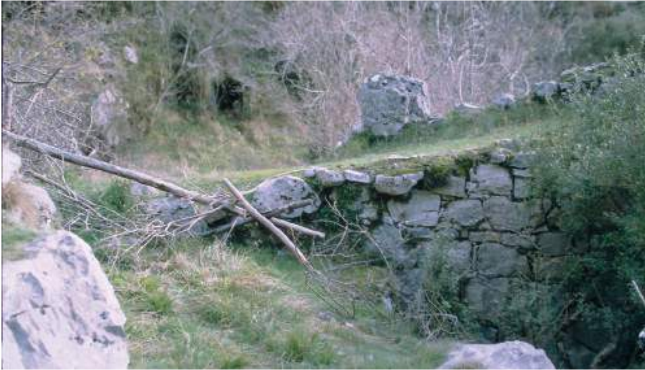
Figura 146. Estribo del puente de Berodia, superpuesto al antiguo camino hacia el puente de La Olla. (J. M. Fdez. Hevia)
