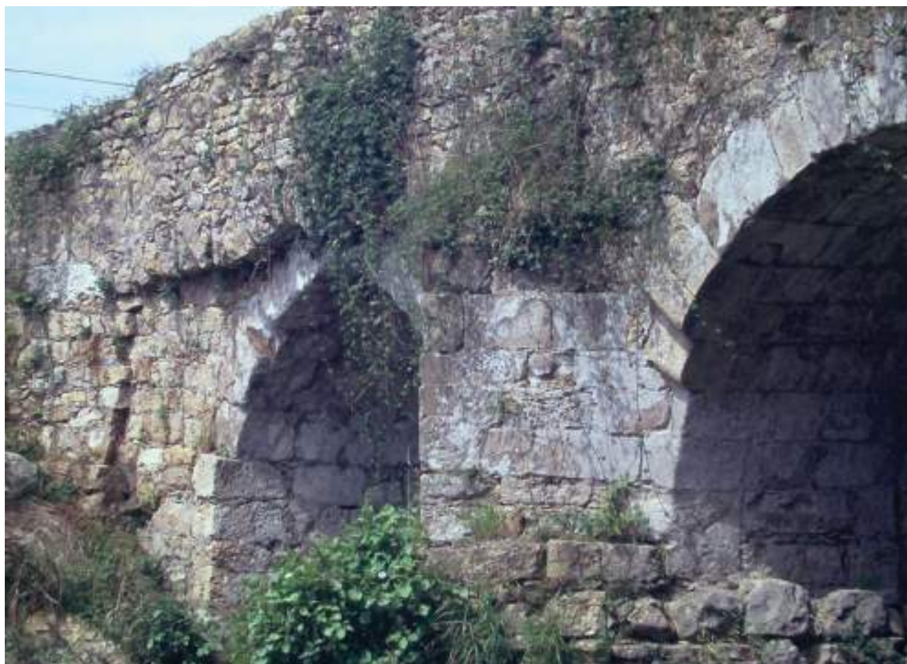
Figura 64. Tres etapas del puente: pila-plataforma originaria; espolón triangular sobre ella (ss. xv-xvi) y, por encima, ensanchamiento del siglo xviii. (J. Belón González)
