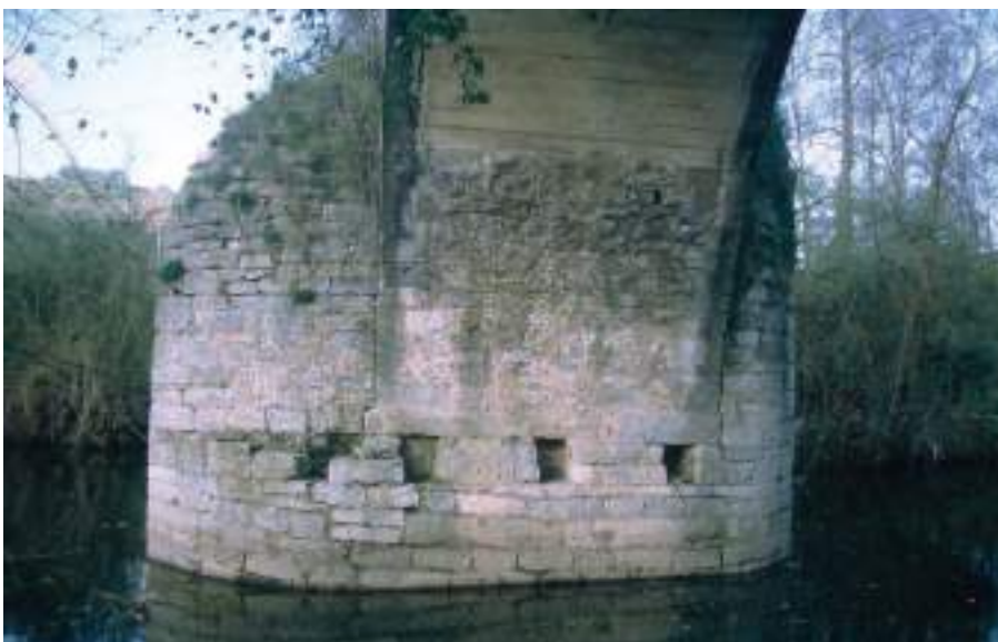
Figura 78. Vista parcial de la segunda bóveda, reconstruida con hormigón y plataforma de apoyo. La pila bascula hacia aguas arriba. (J. M. Fdez. Hevia)
