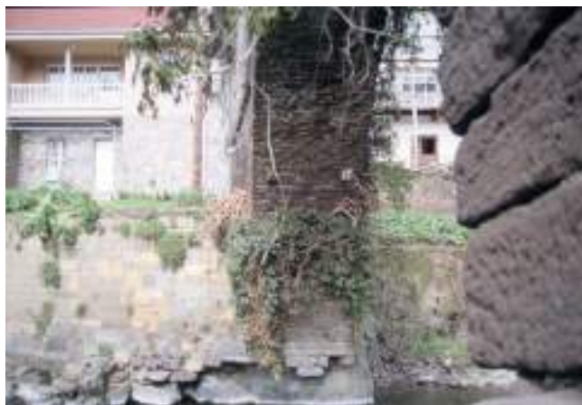
Figura 265. Arranque del arco en el otro margen. (J. Belón González)
