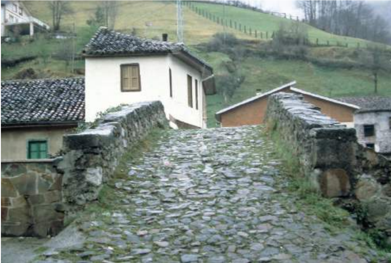
Figura 188. Empedrado del puente. (J. M. Fdez. Hevia)
