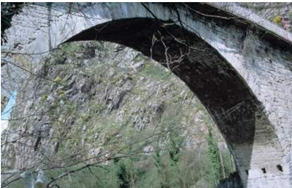
Figura 95. Vista parcial de la bóveda mayor, con su boquilla y fábrica de intradós, aguas arriba. (J. Belón González)
