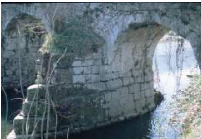
Figura 66. Tajamar de la pila-plataforma adosado a esta, en forma de huso. (J. Belón González)
