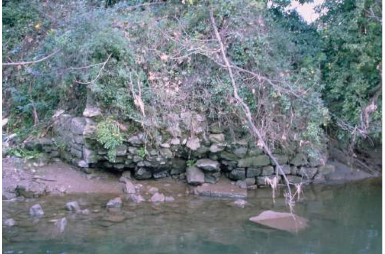
Figura 101. Restos del puente antiguo de Santianes, fuera del camino costero, en las inmediaciones de Colunga. (J. M. Fdez. Hevia)
