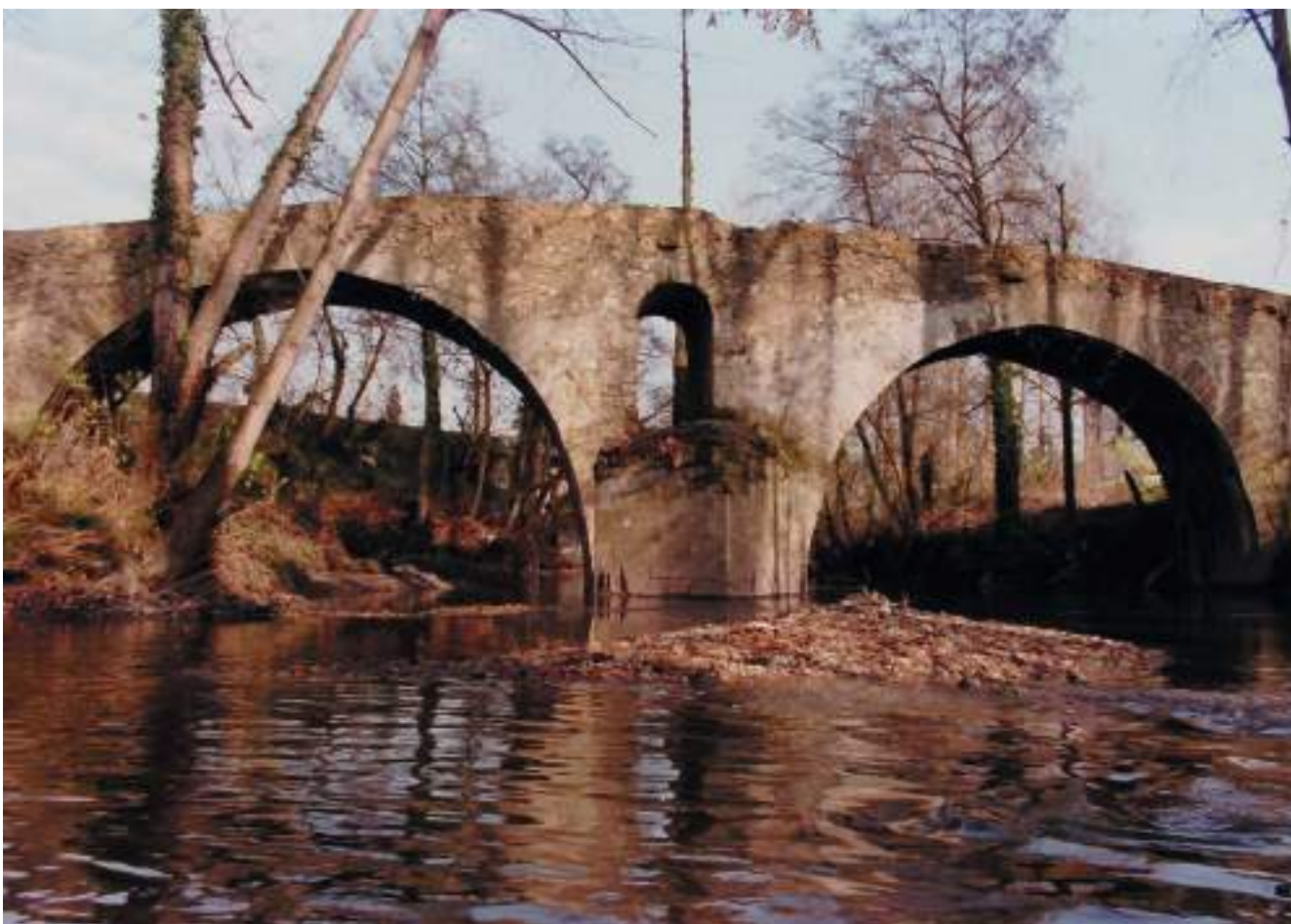
Figura 56. Panorámica, aguas arriba, del puente de Colloto a fines del siglo xx. (J. M. Fdez. Hevia)
