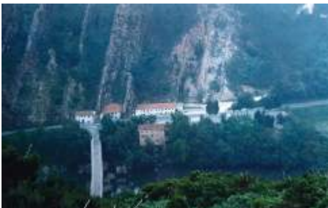
Figura 92. Panorámica del puente, observándose el quiebro de la planta causado por las reconstrucciones. (Fotografía realizada por un vecino de Peñaflor)
