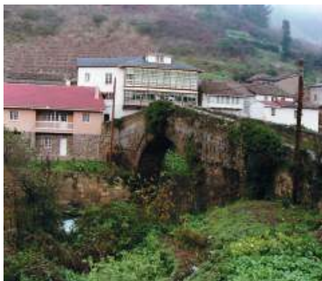
Figura 260. Vista del puente a finales del siglo XX. (Elena Ruiz)
