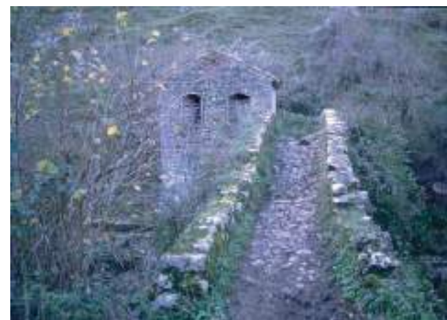
Figura 126. Puento de Saleras. (J. M. Fdez. Hevia)
