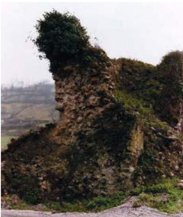
Figura 14. Sección del lado cortado del puente. (Elena Ruiz)
