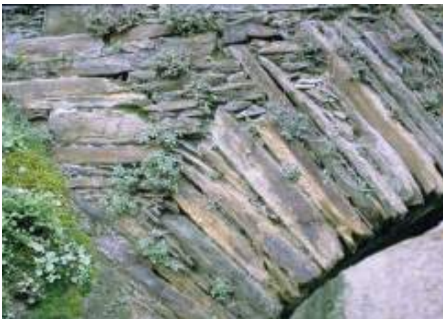
Figura 117. Dovelas de esquistos pizarrosos en las boquillas de aguas arriba. (J. M. Fdez. Hevia)
