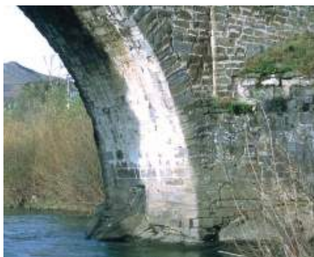
Figura 195. Unión del tajamar con el arranque del arco. (J. M. Fdez. Hevia)
