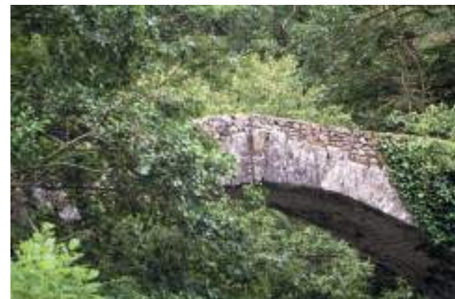
Figura 172. Detalle del arco, aguas abajo. (J. M. Fdez. Hevia)
