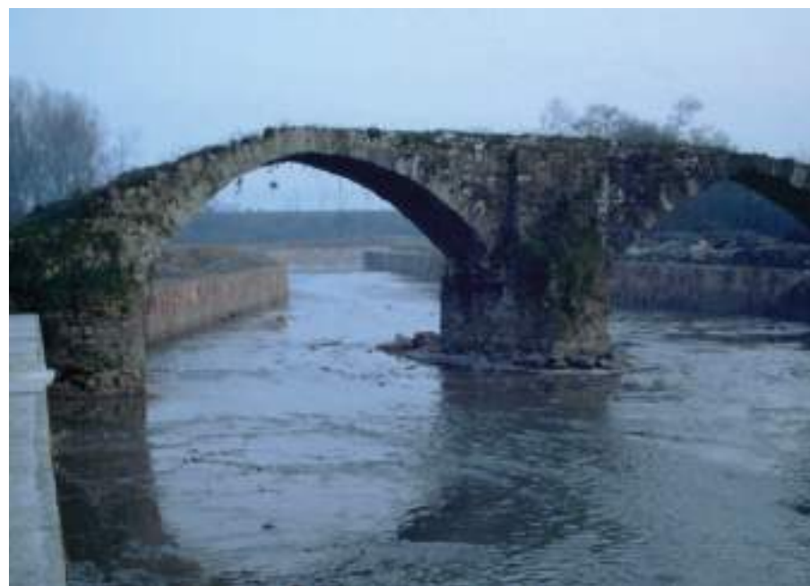
Figura 31. Vista del puente, aguas abajo. (J. Belón González)
