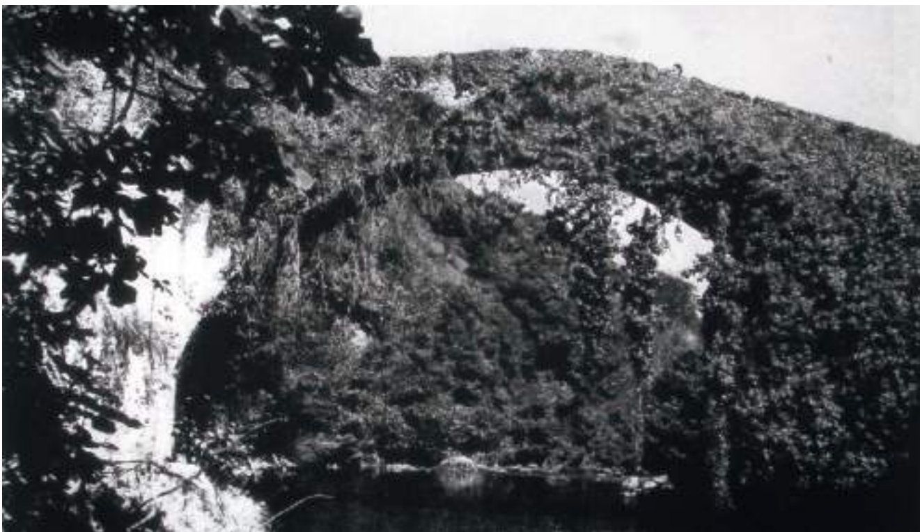
Figura 212. Vista del puente aguas abajo. (Carlos Fernández Casado, Historia del puente en España)
