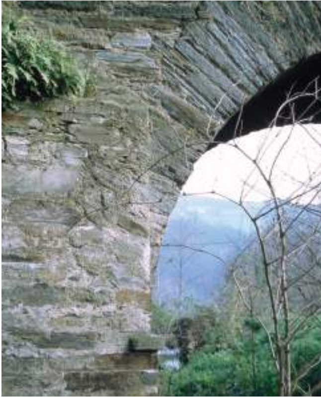
Figura 116. Detalle del arco antiguo del puente de Abres. (J. M. Fdez. Hevia)
