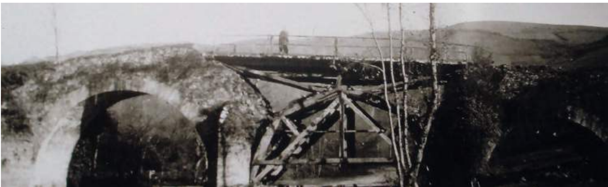
Figura 75. Encimbrado del arco (1937). (Delegación del Estado para Prensa y Propaganda, BNE)
