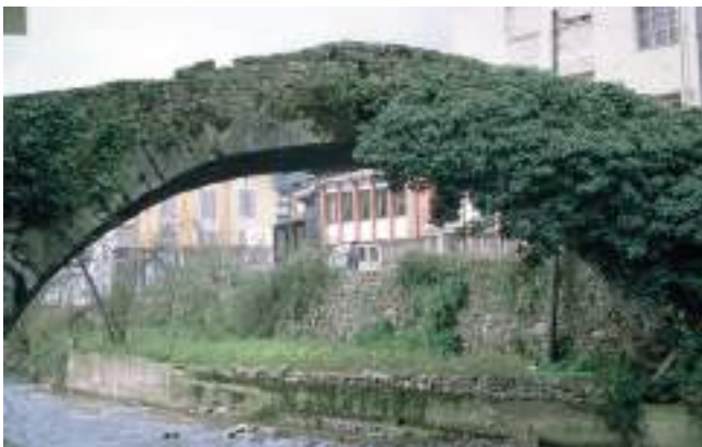
Figura 189. Detalle del arco, aguas abajo. (J. M. Fdez. Hevia)
