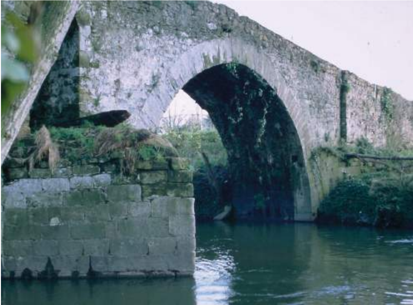
Figura 62. Vista aguas arriba, observándose en el estribo el ensanchamiento del siglo XVIII.
