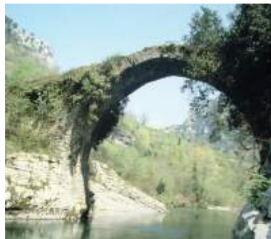
Figura 159. Vista general del puente. (J. Belón González)
