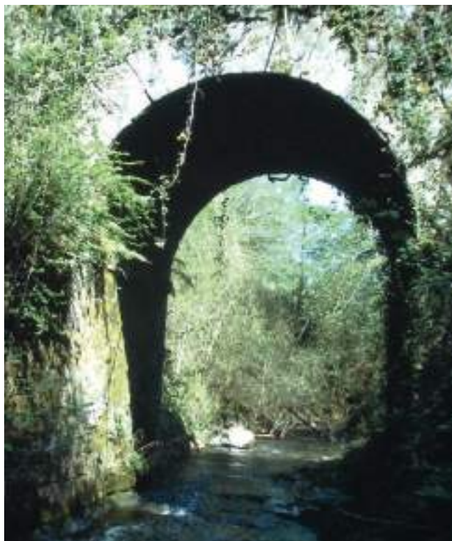
Figura 167. Vista aguas arriba. (J. Belón González)
