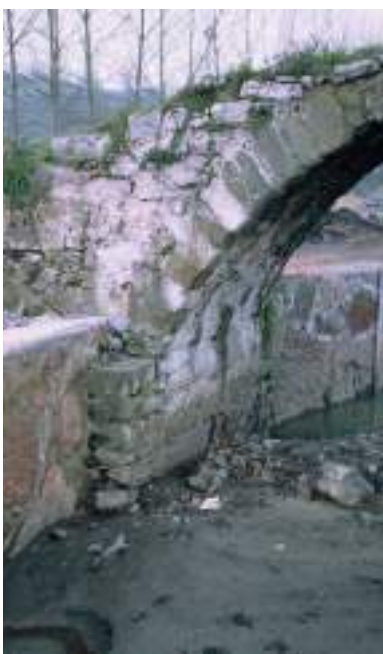
Figura 30. Detalle de la unión muro-estribo, tras el encauzamiento del río. (J. M. Fdez. Hevia)
