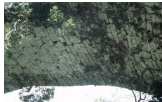
Figura 173. Detalle del intradós en la zona de la clave. (J. Belón González)
