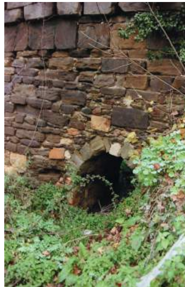
Figura 266. Detalle del arquillo de desagüe en el estribo. (Elena Ruiz)
