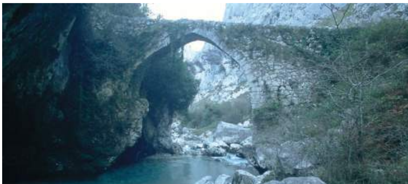
Figura 133. Vista frontal, aguas arriba. (J. M. Fdez. Hevia)
