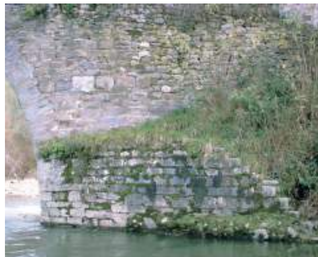
Figura 193. Muro de encauzamiento, aguas abajo, margen izquierdo. (J. M. Fdez. Hevia)
