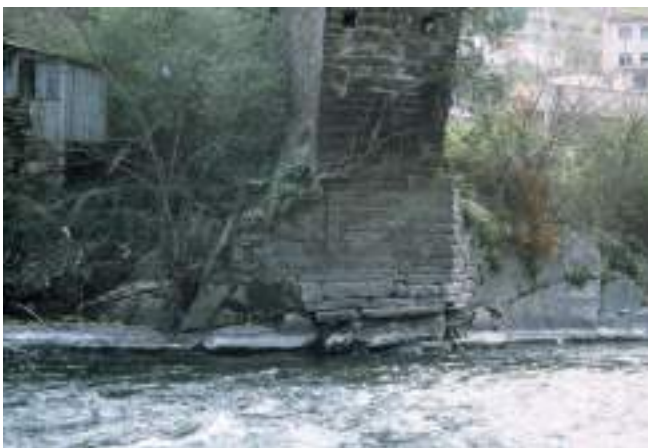
Figura 263. Arranque del arco. (J. Belón González)
