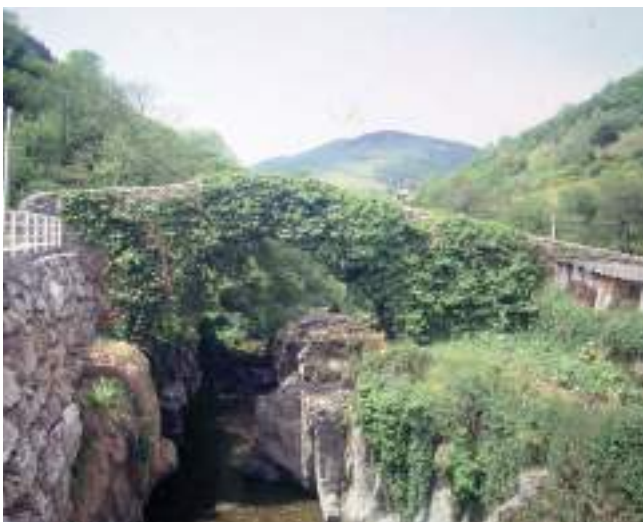
Figura 252. Vista frontal, aguas arriba.
