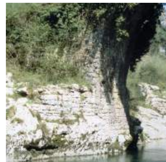
Figura 155. Cimentación en la margen izquierda. (J. Belón González)
