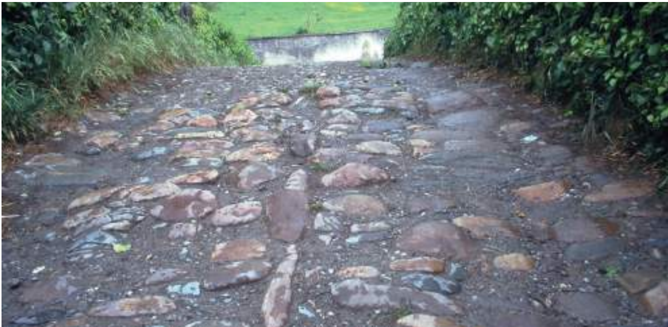
Figura 231. Calzada del puente. (J. M. Fdez. Hevia)
