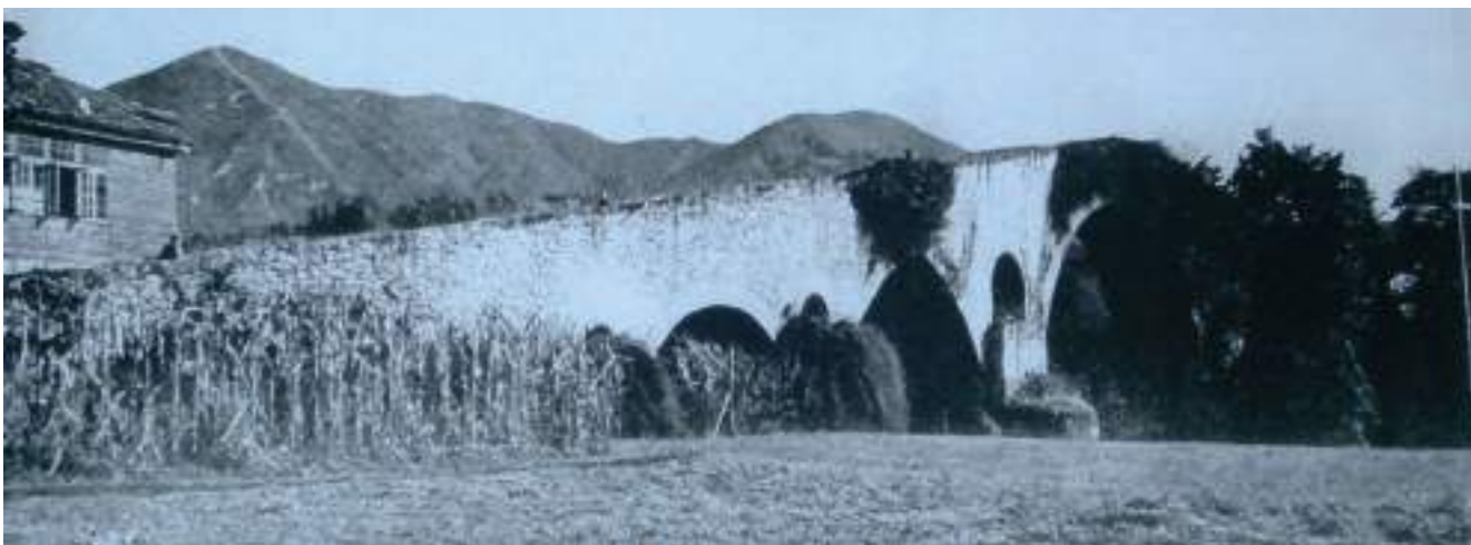
Figura 48. Estribo, aguas arriba, del lado de Parres tras las intervenciones realizadas en los años cuarenta. (Carlos Fdez Casado, Historia del puente en España)
