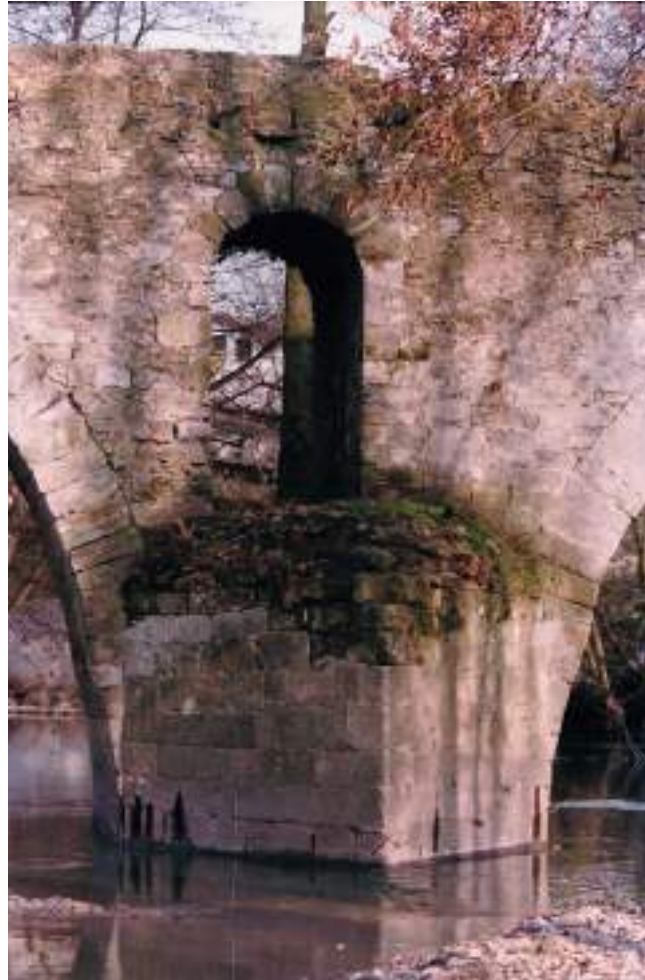
Figura 58. Arco de descarga asimétrico respecto al tajamar, con posibles obras en su lado izquierdo. (J. M. Fdez. Hevia)
