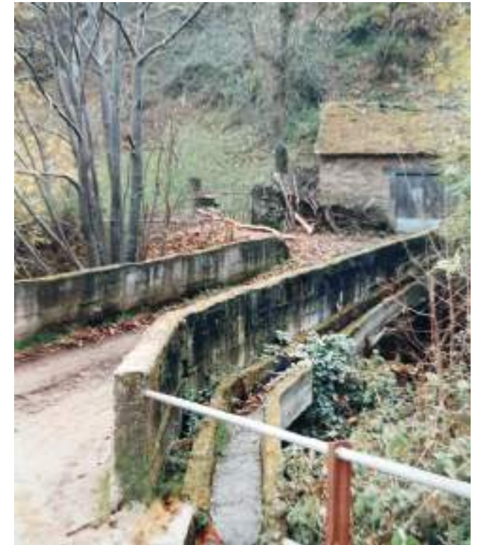
Figura 237. Pretiles y canalización de hormigón adosados a la fábrica antigua. (Elena Ruiz)
