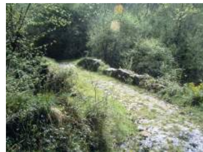
Figura 169. Vista de la calzada. (J. Belón González)
