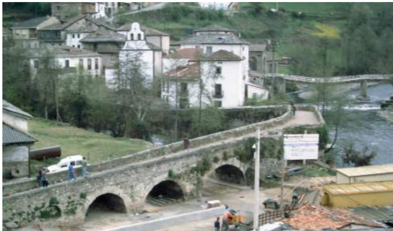
Figura 247. Obras de finales del siglo XX. (J. Belón González)
