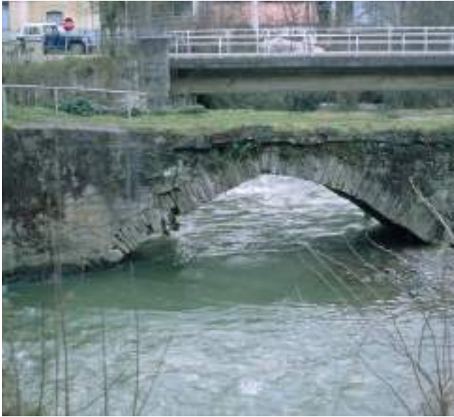
Figura 202. Vista, aguas arriba. (J. Belón González)
