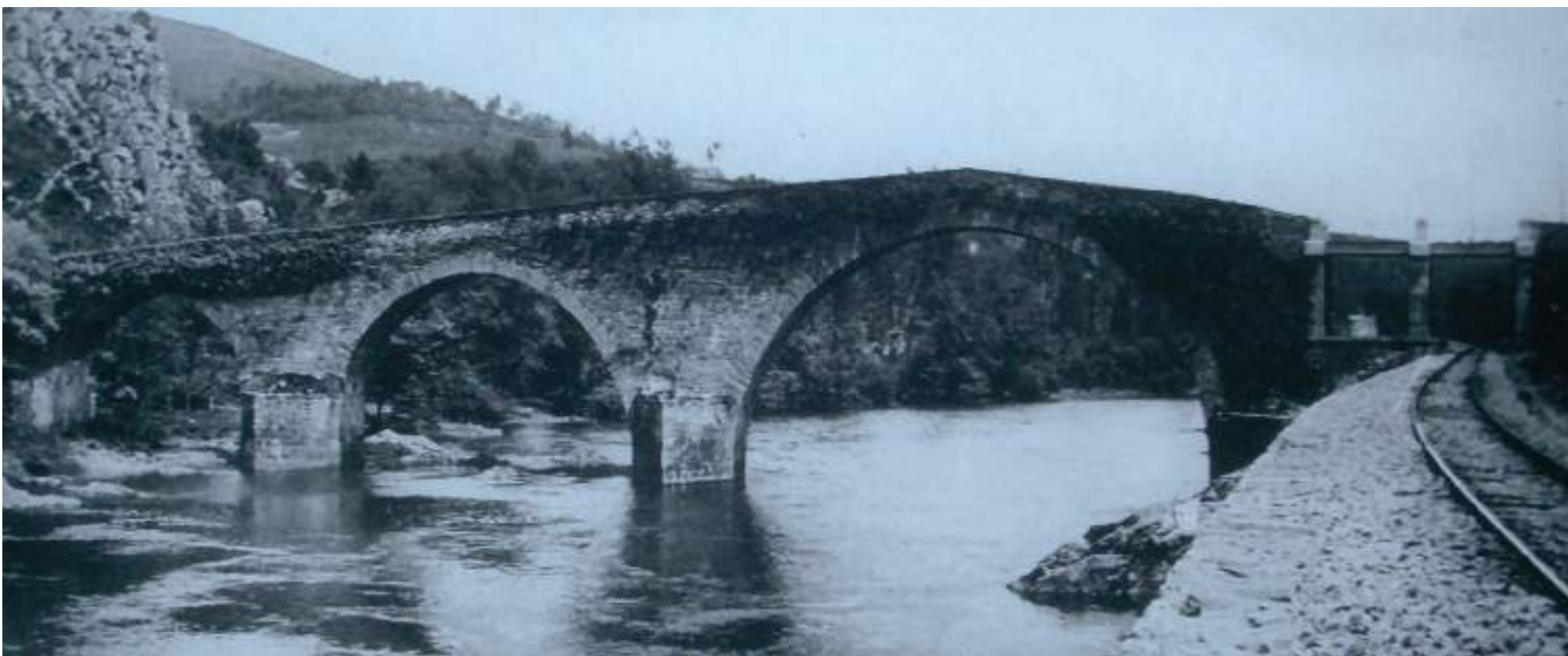
Figura 88. Panorámica, aguas abajo, durante la adaptación a la vía férrea. (Col. M. Carrasco Marqués)
