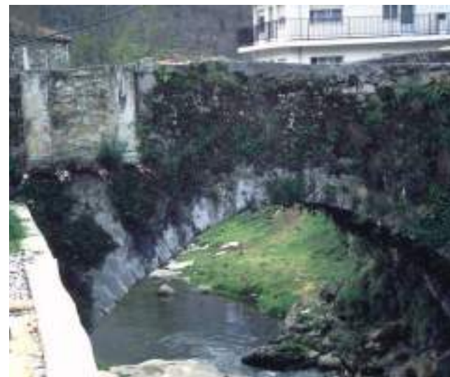
Figura 137. Vista, aguas arriba. (J. Belón González)
