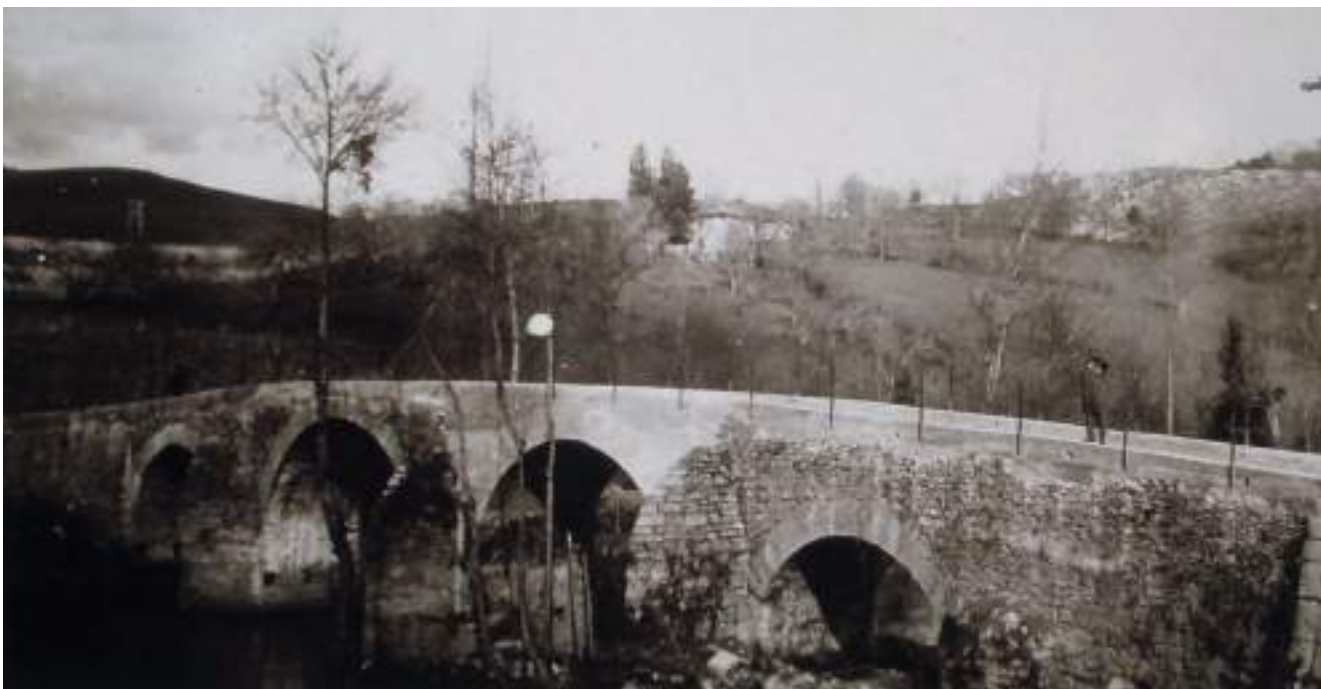
Figura 77. «Puente de Gallegos, sobre el Nora, reconstruido en 20 días». (Delegación del Estado para Prensa y Propaganda, BNE)
