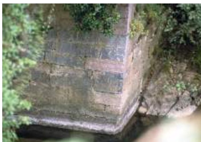
Figura 179. Cimentación del puente. (J. M. Fdez. Hevia)
