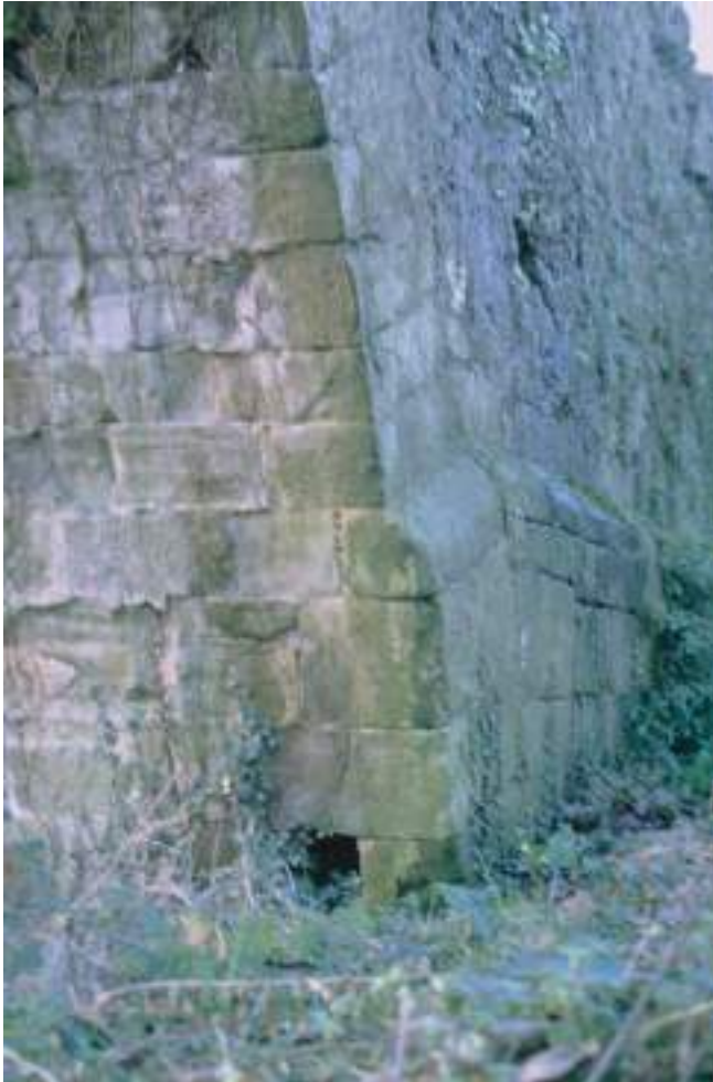
Figura 57. Detalle del arranque del arco y del estribo izquierdo, advirtiéndose el cambio de fábrica a partir de la moldura. (J. M. Fdez. Hevia)
