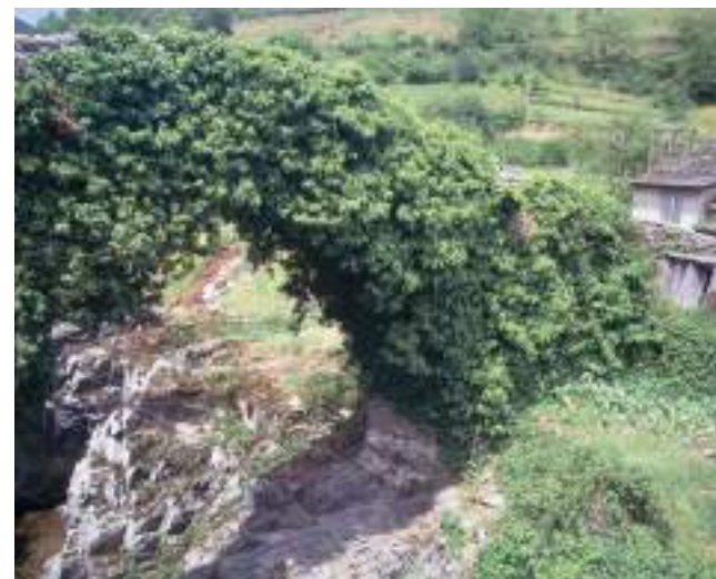
Figura 253. Vista lateral, aguas arriba, con arranque del arco, desde la margen izquierda. (J. M. Fdez. Hevia)
