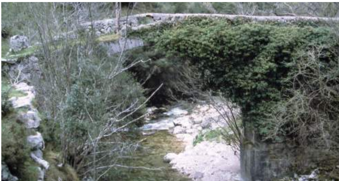
Figura 145. Vista del puente de Berodia, aguas arriba. (J. Belón González)
