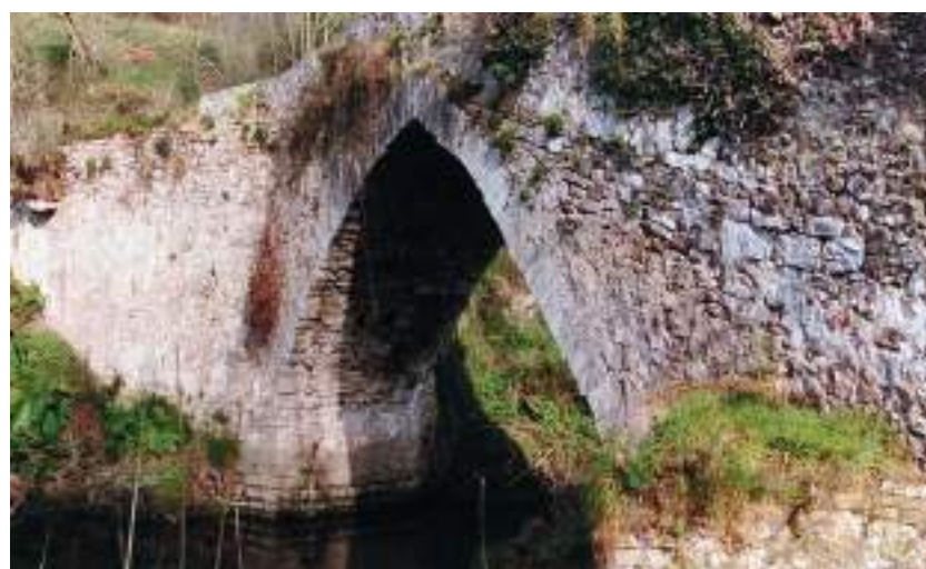
Figura 85. Detalle de la diversidad de fábricas, testimonio de sucesivas intervenciones. (J. Belón González)
