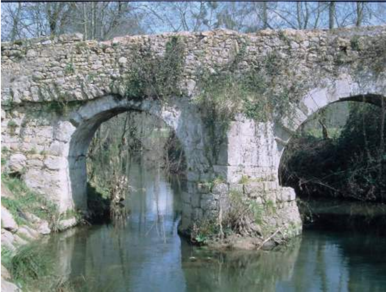
Figura 65. Detalle del ensanchamiento: en un caso, a través del listel; en el otro, recreciendo las primeras dovelas. (J. M. Fdez. Hevia)
