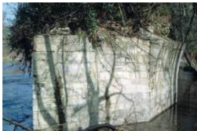
Figura 215. Detalle de la fábrica en la pila pequeña, en la orilla de Godos. (J. Belón González)
