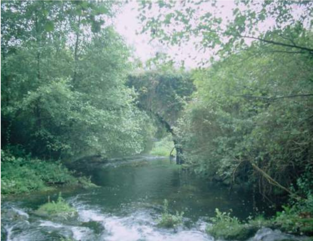
Figura 108. Panorámica del puente de Casquita, enmascarado por la vegetación. (J. M. Fdez. Hevia)
