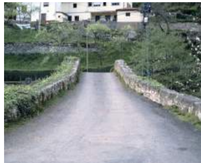
Figura 210. Calzada del puente, con su ensanchamiento. (J. Belón González)
