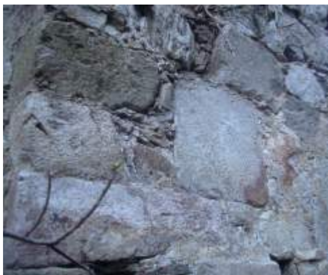
Figura 273. Detalle de la fábrica en el arranque izquierdo de la bóveda mayor. (J. Belón González)
