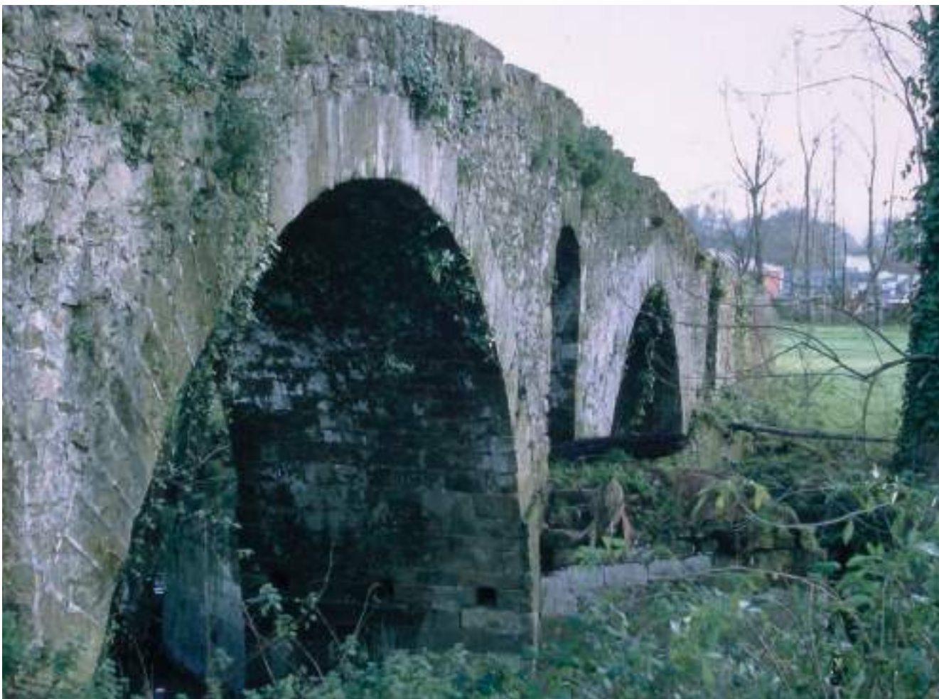
Figura 59. Diferentes alturas de la rasante de las claves. (J. M. Fdez. Hevia)
