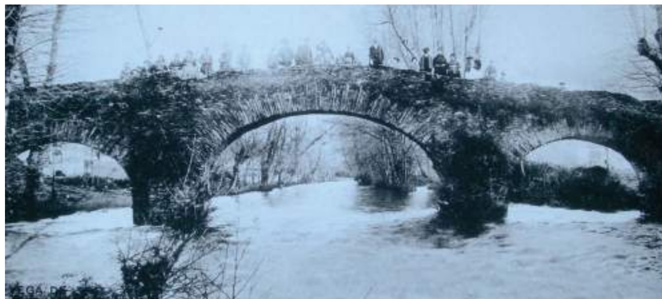
Figura 115. Vista antigua del puente de Piantón, aguas abajo, durante una crecida. (Col. M. Carrasco Marqués)
