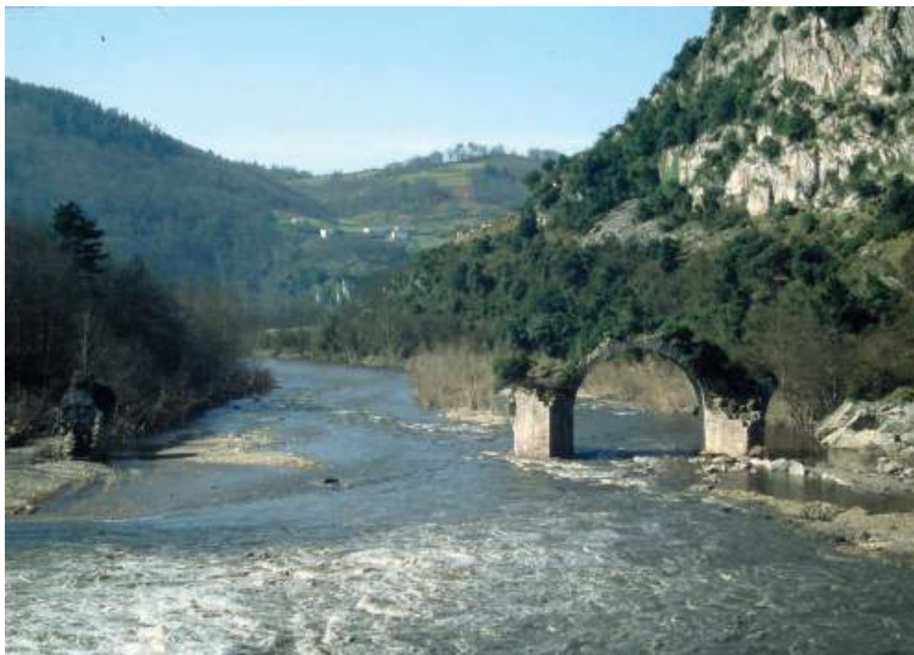
Figura 218. Panorámica de los restos desde la presa de El Furacón. (J. Belón González)
