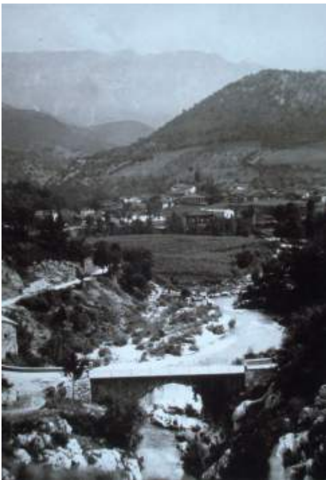
Figura 134. El puente en 1937. Obsérvese el ligero apuntamiento del arco. (BNE)
