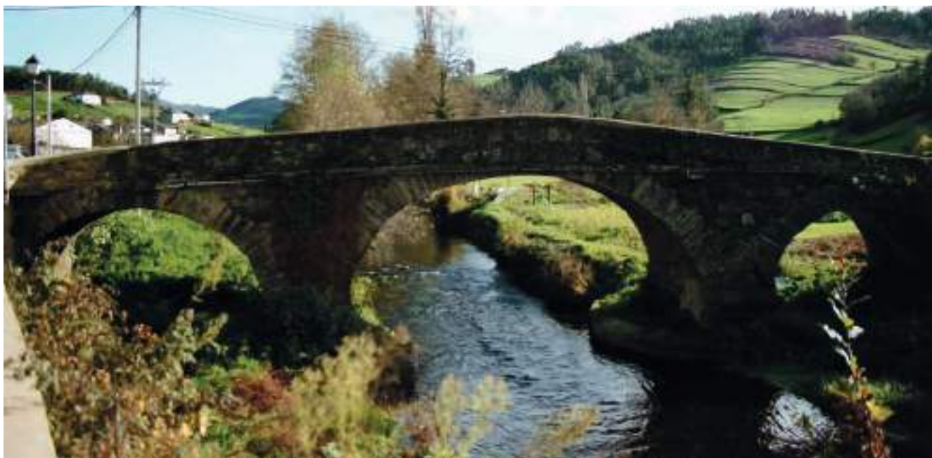
Figura 113. Vista del puente, aguas abajo. (Elena Ruiz)
