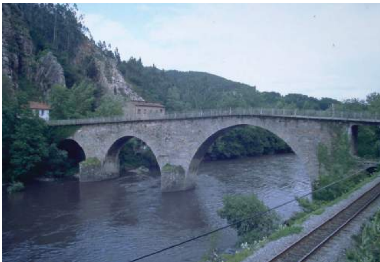
Figura 86. Vista general, aguas abajo. (J. M. Fdez. Hevia)
