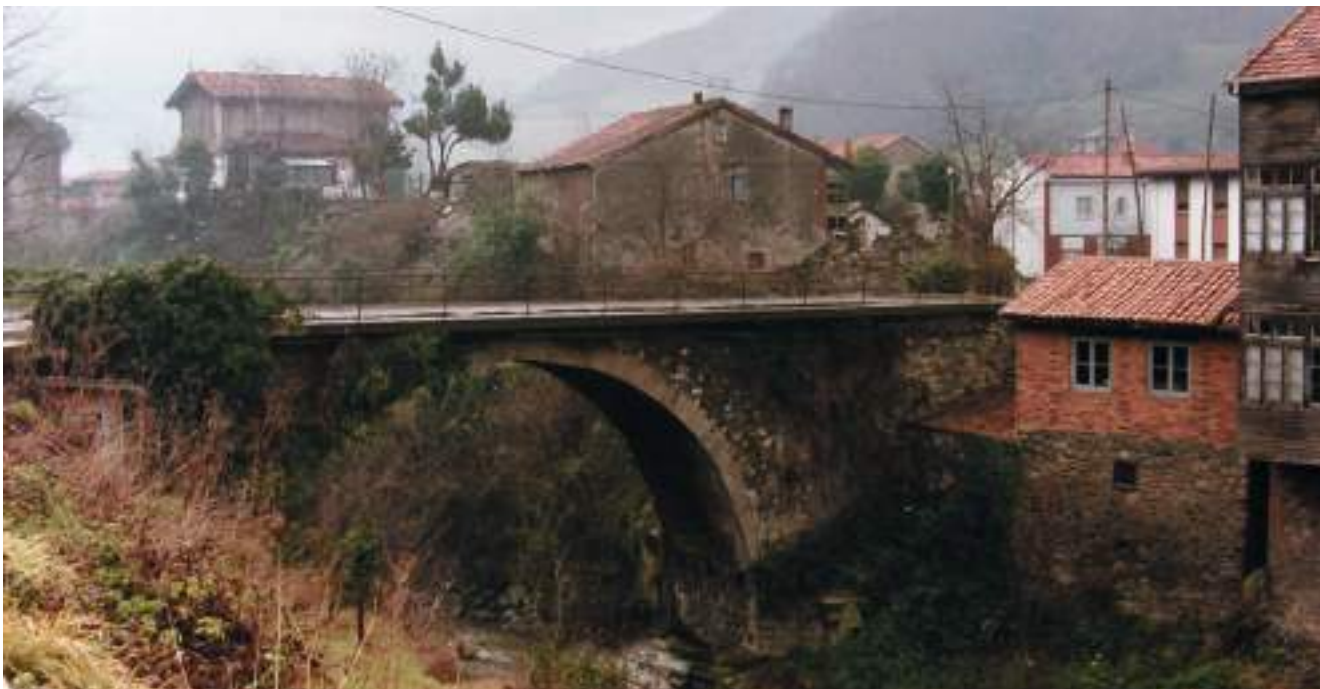
Figura 5. Puente de Vega del Ciego
