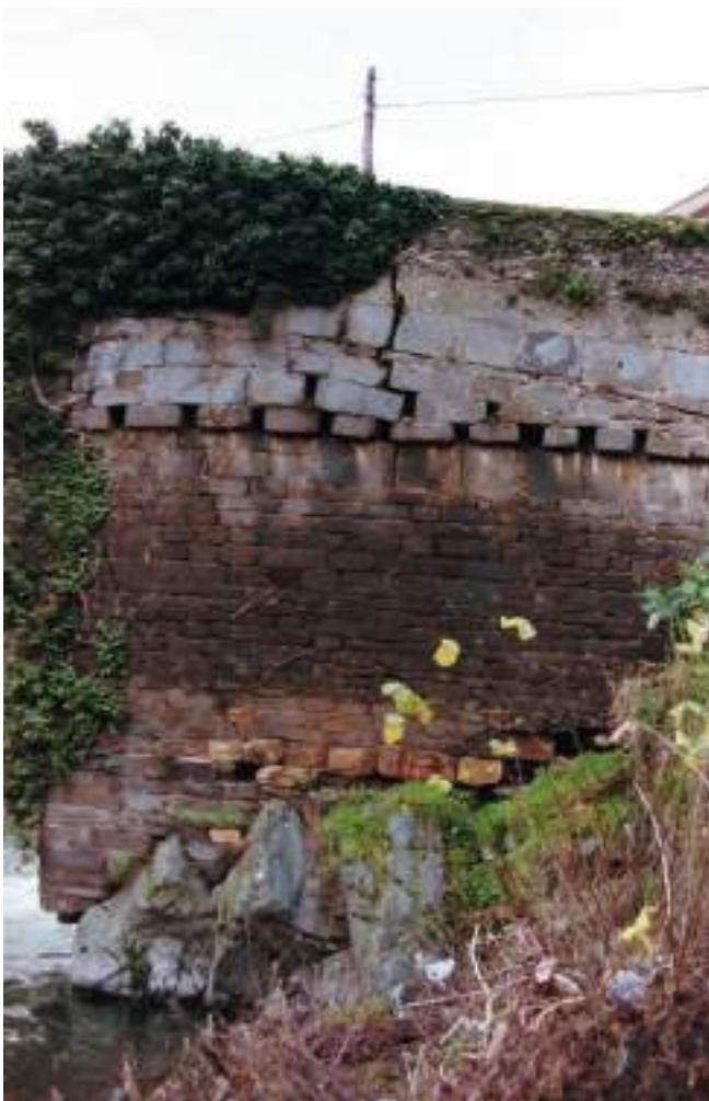
Figura 267. Arranque y paramentos del estribo. (Elena Ruiz)
