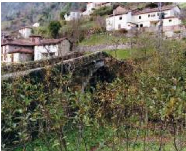
Figura 209. Vista aguas abajo. (Elena Ruiz)
