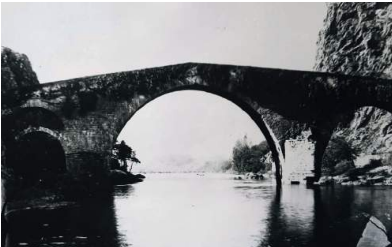
Figura 87. Vista aguas arriba, antes de las intervenciones con motivo de la construcción del ferrocarril. (RIDEA-Fondo Mas)
