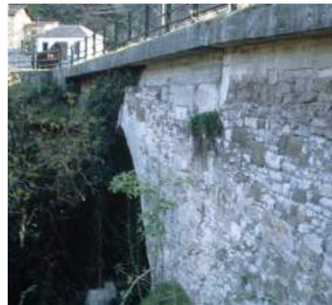
Figura 204. Tímpanos en el paramento de aguas abajo. (J. Belón González)
