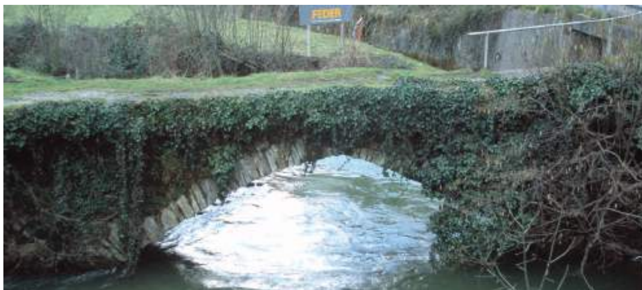
Figura 201. Vista, aguas abajo. (J. Belón González)
