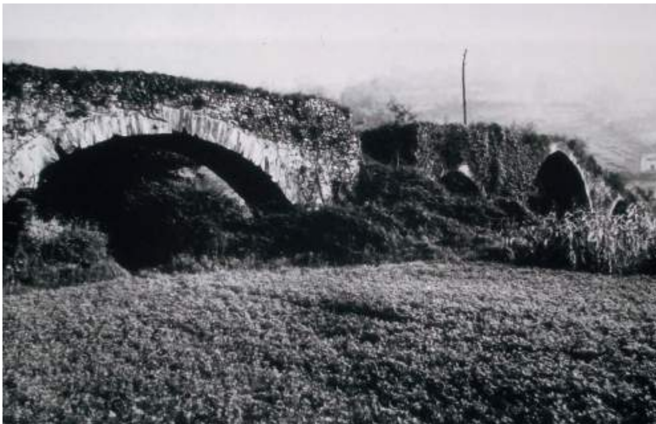
Figura 10. Vista, aguas abajo, con uno de los arcos destruidos. (Carlos Fernández Casado, Historia del puente en España)
