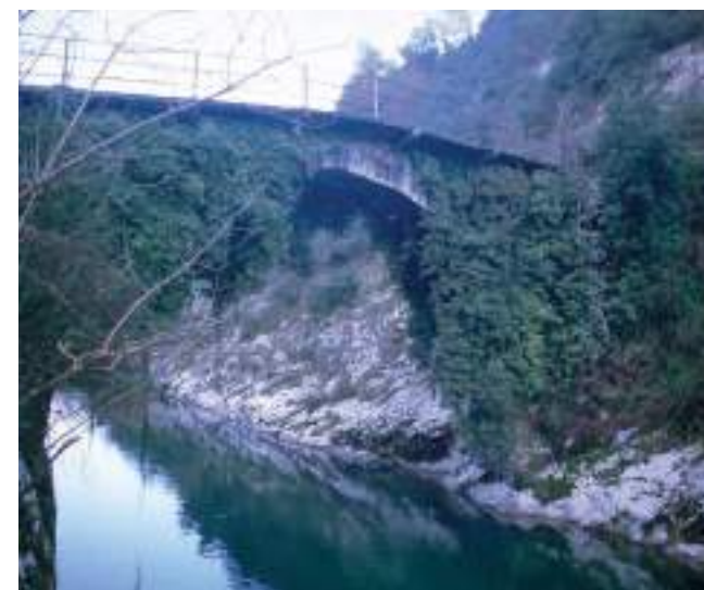
Figura 161. Vista general del puente con su tablero de ensanchamiento. (J. Belón González)
