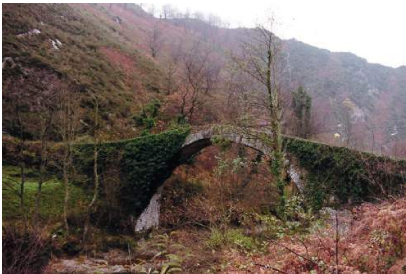
Figura 170. Vista general, aguas abajo, del Puente Dobra. (Elena Ruiz)
