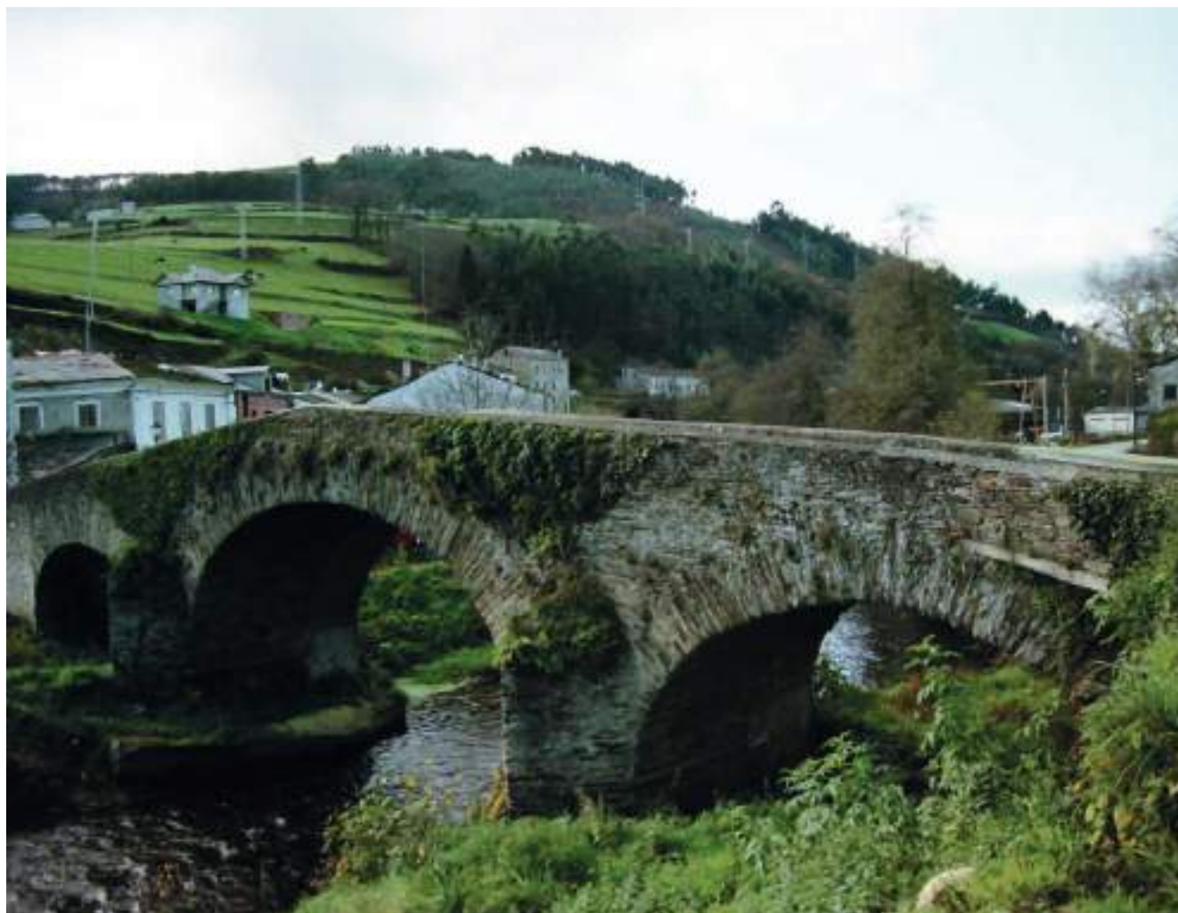
Figura 111. vista general del puente, aguas arriba. (Elena Ruiz)
