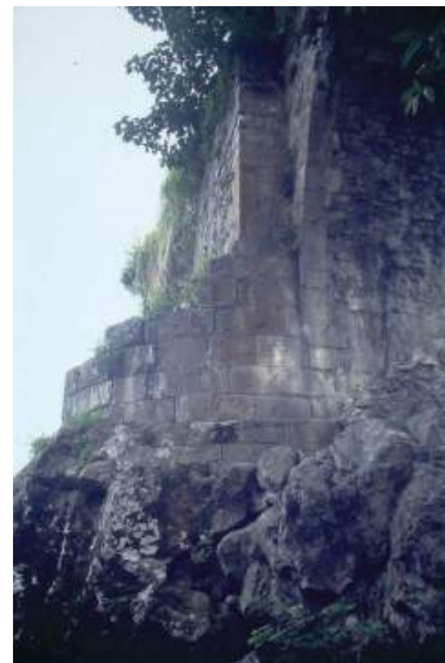
Figura 52. Pila central y arranque del arco cercano a la villa, advirtiéndose un cambio de fábrica. (J. M. Fdez. Hevia)
