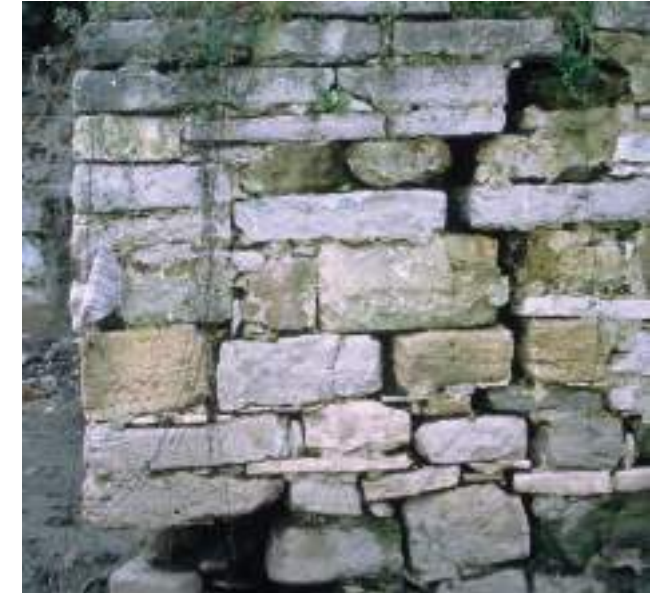
Figura 27. Detalle de la fábrica del tajamar. (J. M. Fdez. Hevia)
