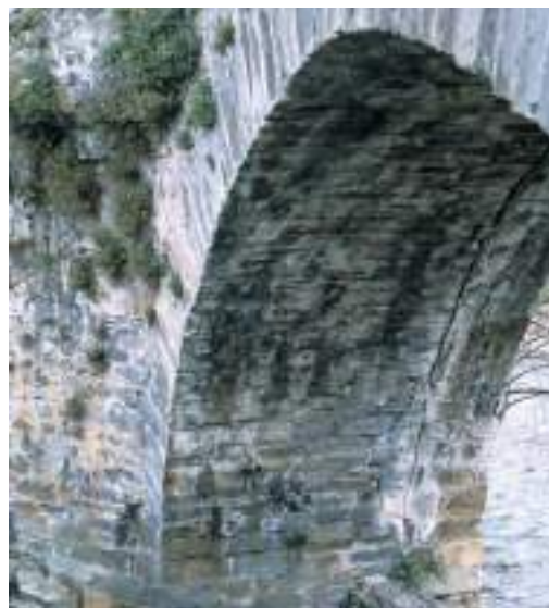
Figura 243. Fábrica del intradós de la primera bóveda. (J. Belón González)
