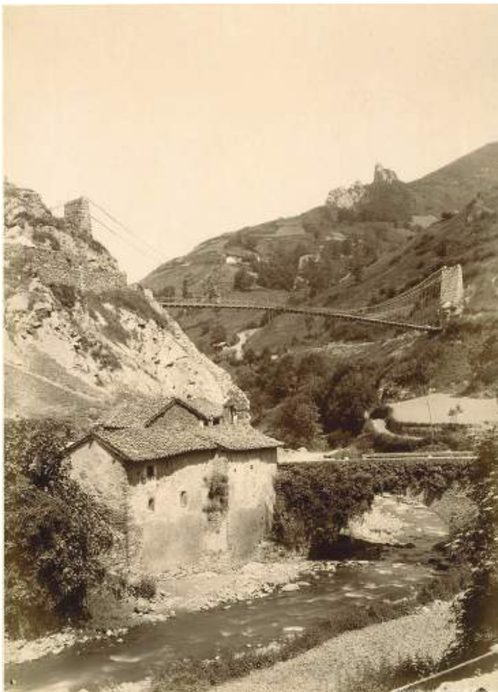
Figura 2. Vista del puente de los Fierros, hacia 1884. Al fondo, el puente colgante provisional levantado durante las obras del trazado ferroviario de Pajares. (P. Sauvanaud, BNE)
