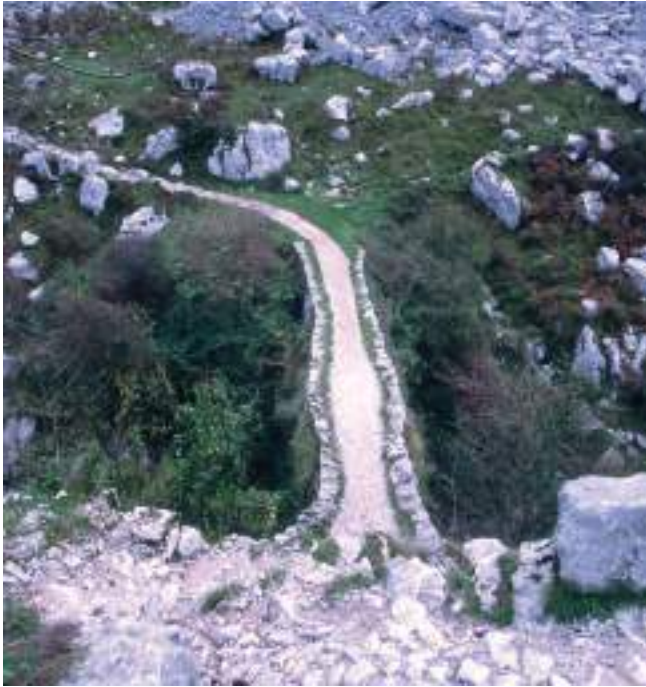
Figura 130. Vista en planta de la calzada del puente. (J. M. Fdez. Hevia)
