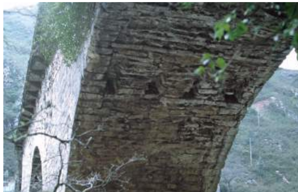
Figura 96. Intradós de la última bóveda reconstruida probablemente en al menos dos ocasiones. (J. Belón González)
