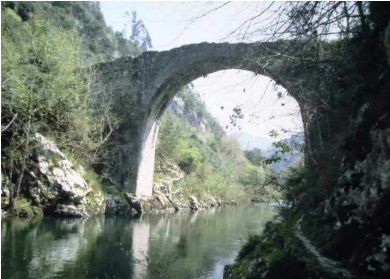
Figura 166. Vista general del puente de Robriguero, aguas arriba. (J. Belón González)
