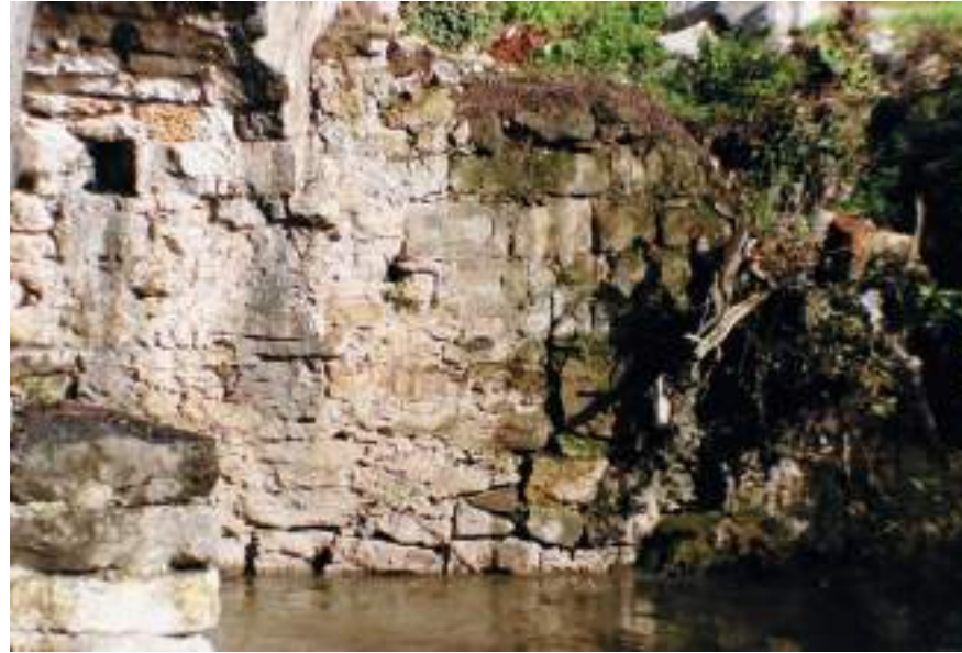
Figura 26. Detalle del espolón, con múltiples refacturas. (Elena Ruiz)
