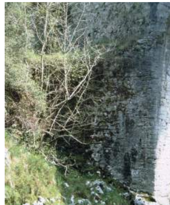
Figura 164. Estribo y tajamar de la margen izquierda. (J. Belón González)
