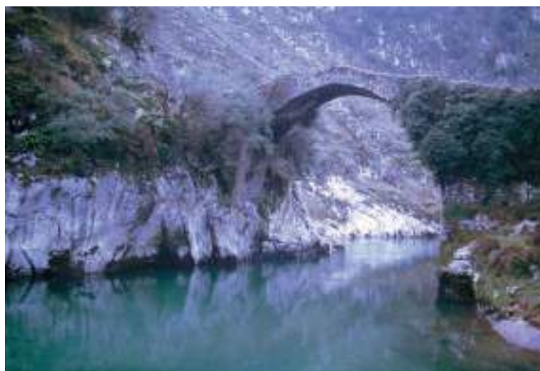
Figura 154. Vista aguas arriba. (J. Belón González)
